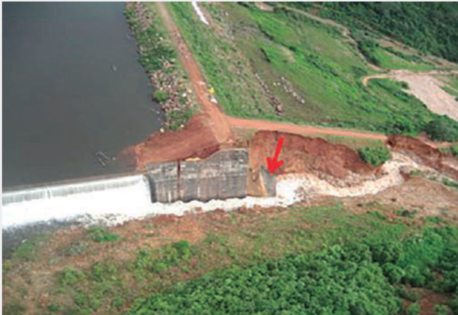
Figura 1.31 - Em 12 de maio de 2009, o muro de concreto que servia de apoio para o aterro da barragem começou a ceder e a primeira placa, do lado jusante, perdeu a sustentação e destacou-se. Seguiu-se a isso o colapso do restante do muro e do vertedouro, visível à esquerda (Internet)
