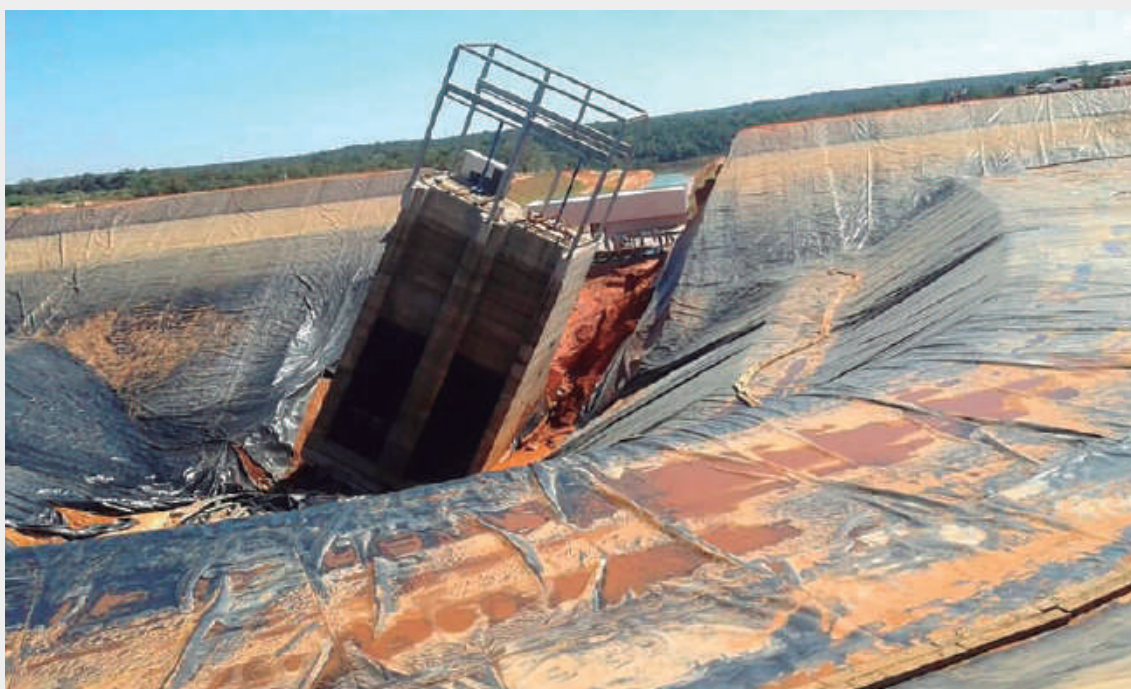
Figura 1.34 – PCH Inxu: adernamento da estrutura da tomada d'água na câmara de carga da usina, no rio do Sangue, em junho de 2015 (ANA, 2015)
