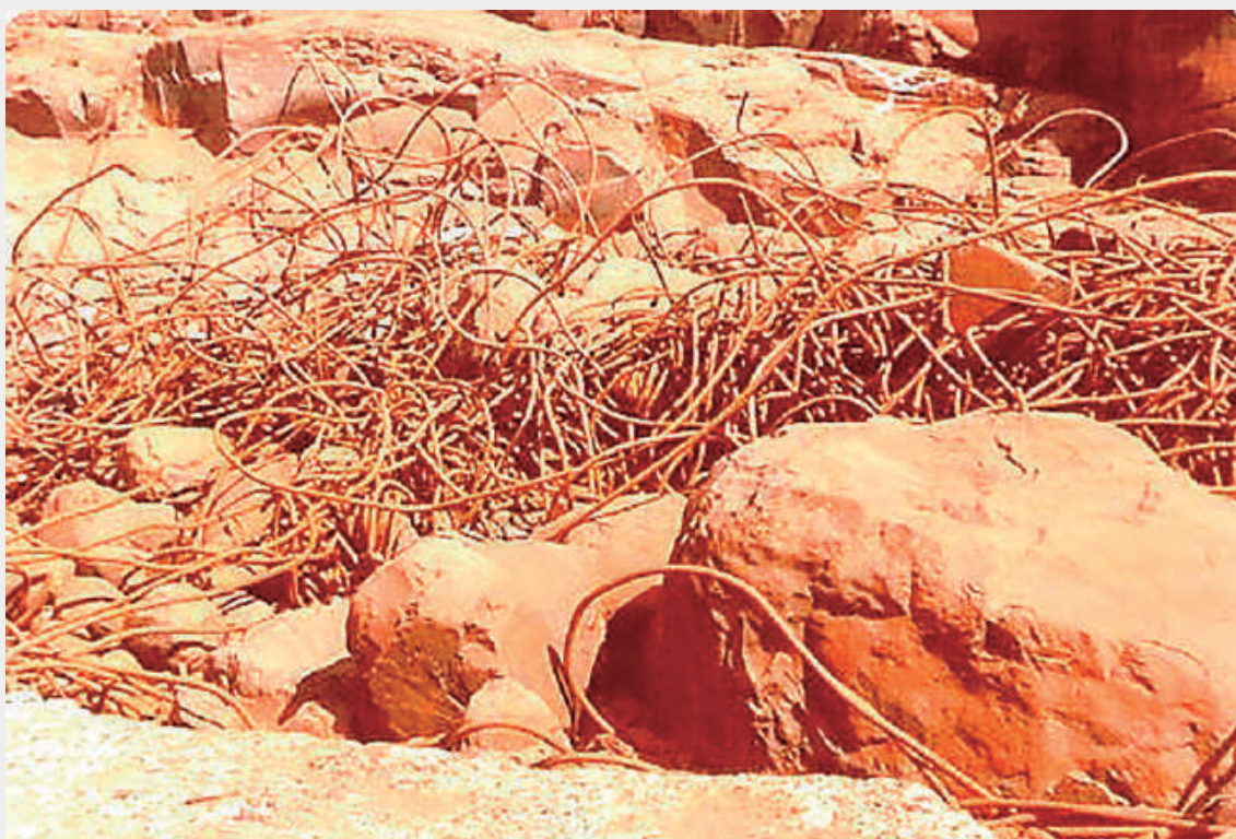
Figura 1.48 – Bacia de dissipação da UHE Marimbondo, rio Grande (MG). As ferragens são o que sobrou do concreto de revestimento do piso da bacia após erosão causada pela operação assimétrica de comportas (Carvalho, E., 2016)
