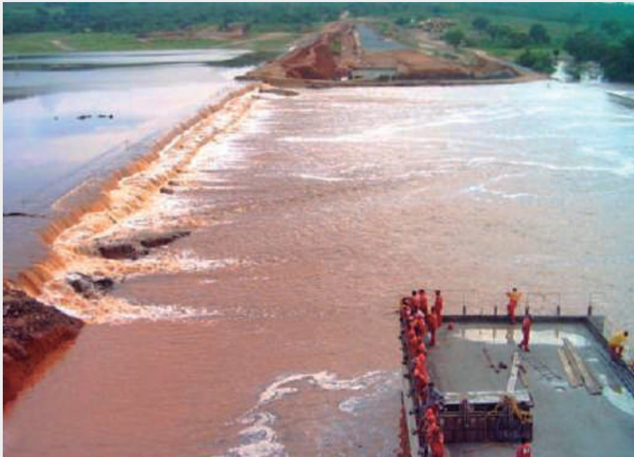
Figura 1.13 - Galgamento da ensecadeira da barragem de Bandeira de Mello (BA), em 2005, por excedência de vazão em relação à admitida no projeto (Facchinetti, 2008)
