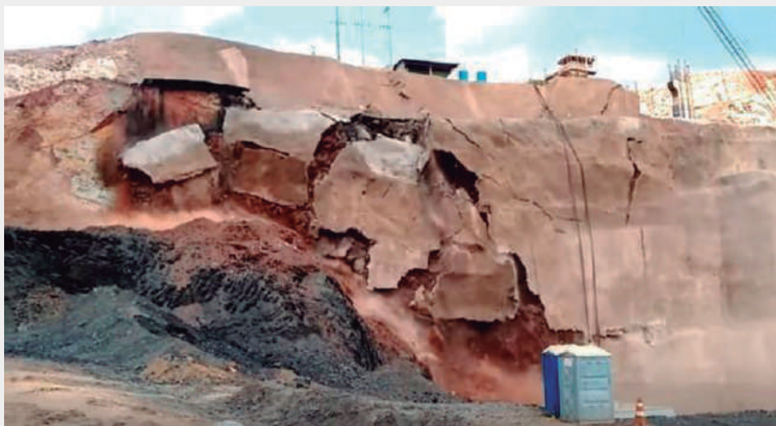
Figura 1.18 – UHE Sinop: desmoronamento da parede de escavação direita da casa de força/canal de fuga (Internet, 2015)
