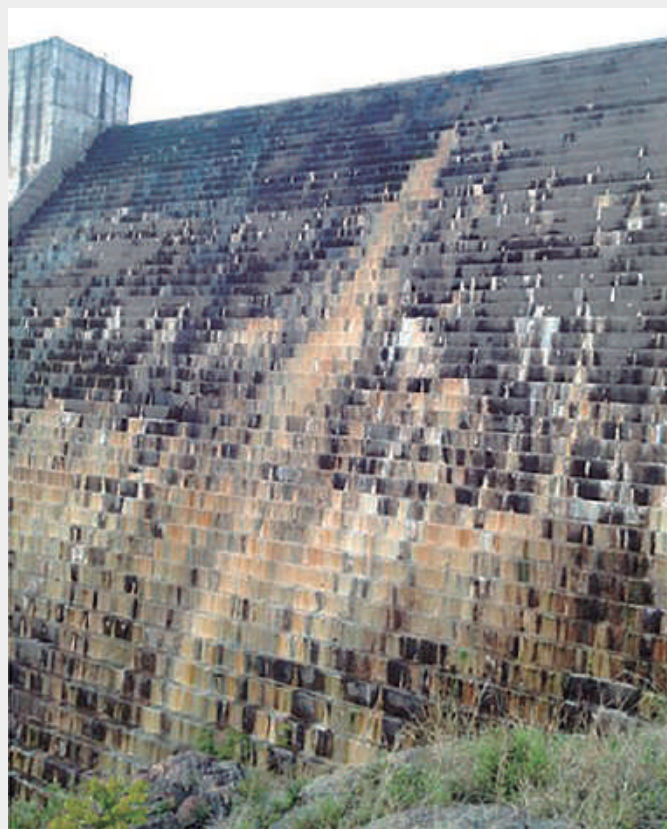
Figura 1.26 – Surgências e deposição de constituintes lixiviados do concreto ao longo dos degraus do paramento jusante de barragem em CCR (Foto dos autores)
