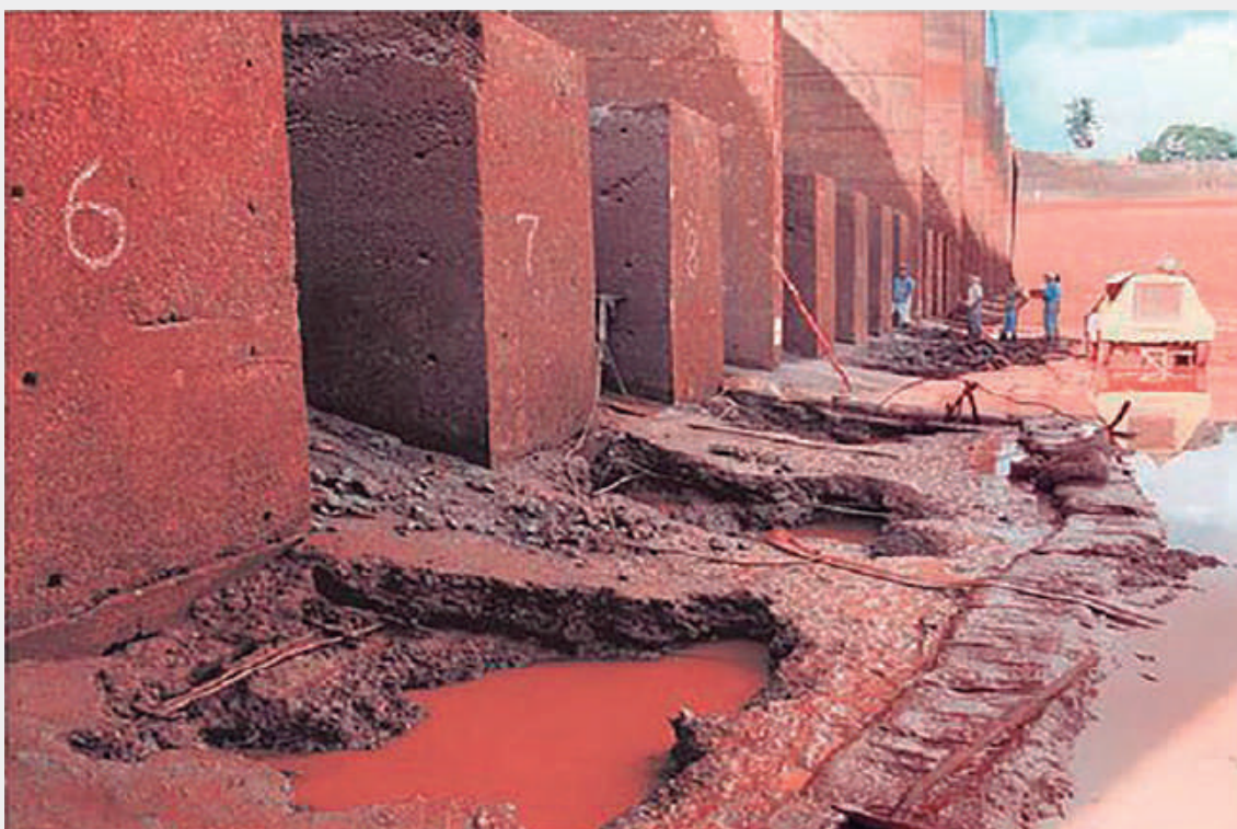
Figura 1.49 - Reparo dos blocos da calha e laje de jusante (Carvalho, E., 2009)
