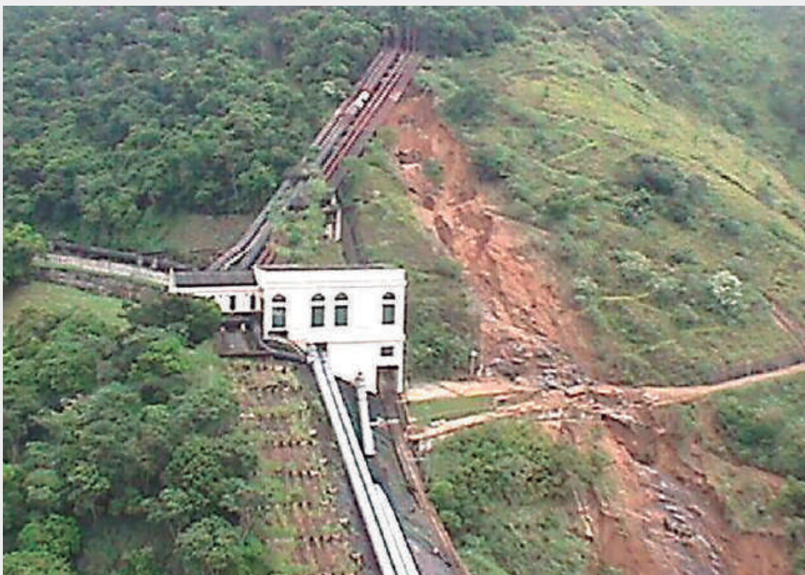
Figura 1.43 – Central Hidrelétrica de Fontes (Light/RJ): a chaminé de equilíbrio metálica, apoiada sobre a encosta, rompeu e causou o desmonte hidráulico de um trecho da encosta, seguido por uma corrida de detritos (Silva & outros, 2005)
