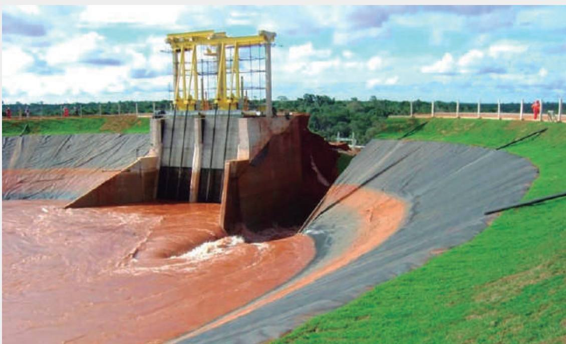
Figura 1.33 – PCH Bocaiúva, no rio Cravari (MT): colapso do aterro no encontro com a tomada d'água na câmara de carga da usina (Internet)
