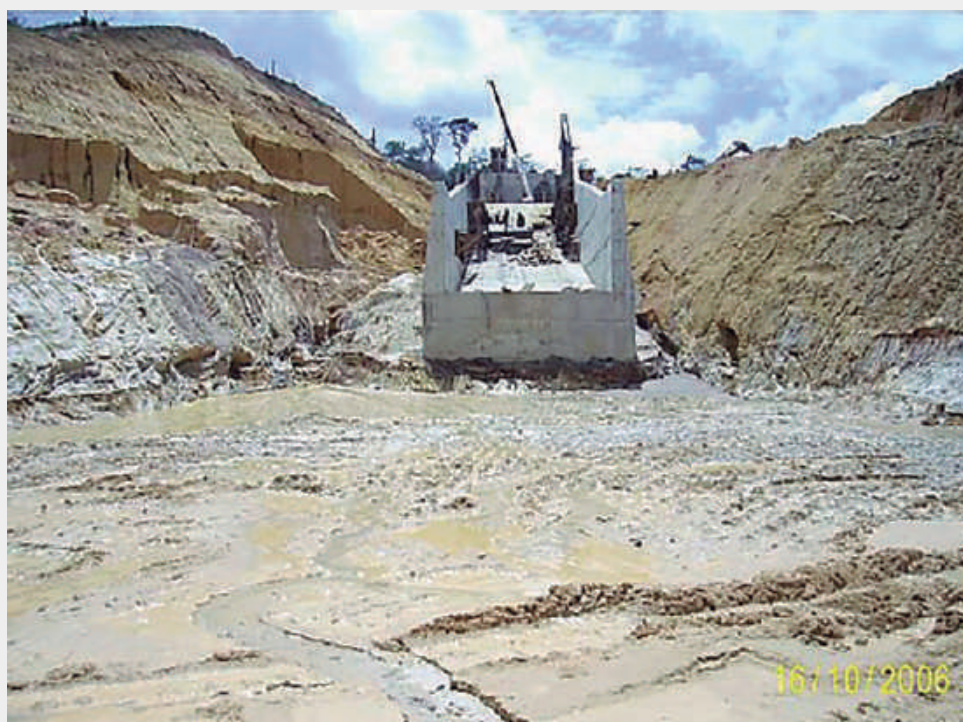
Figura 1.30 - Estrutura da calha do vertedouro ao final da concretagem sobre fundação em solo residual de arenitos (Nieble & outros, 2008)
