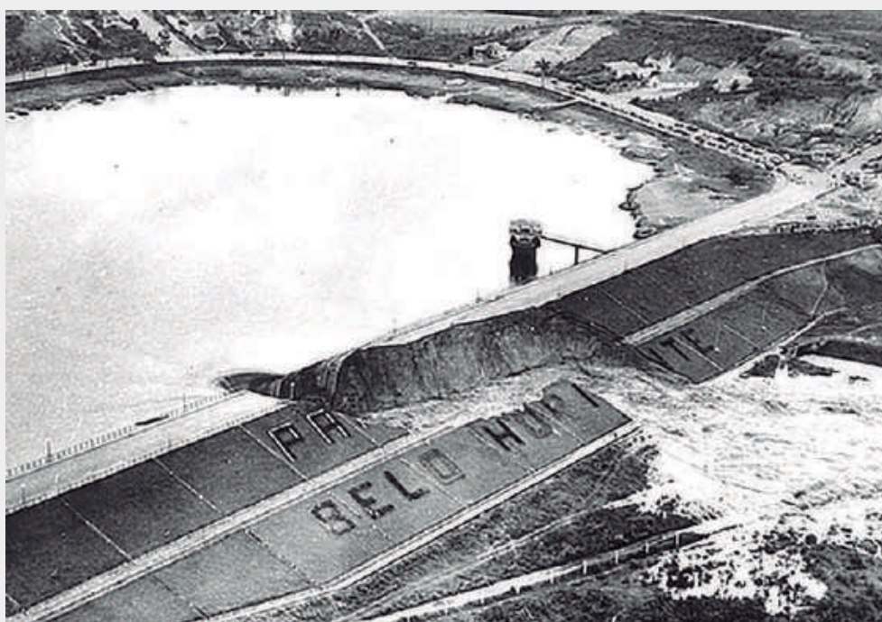
Figura 1.23 - Rompimento da barragem de Pampulha por entubamento ( piping ) (Vargas & outros, 1955)
