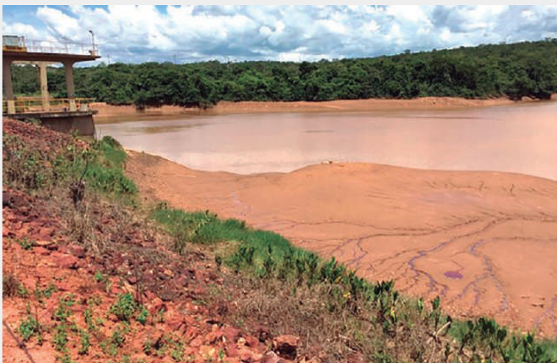
Figura 1.45 – No reservatório da PCH Casca III, no rio Casca (MT), o assoreamento alcançou a soleira da tomada d'água, exigindo a adoção de medidas próprias para a retirada dos sedimentos (Foto dos autores)
