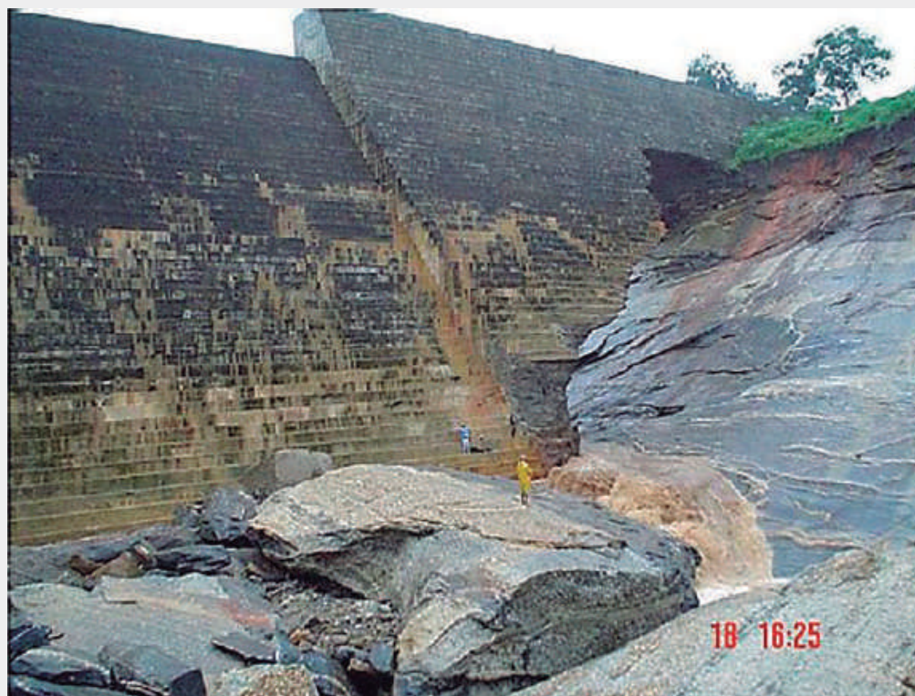
Figura 1.29 - A brecha na ombreira esquerda da barragem de Camará (PB) antes do colapso do arco (Silva & outros, 2004)
