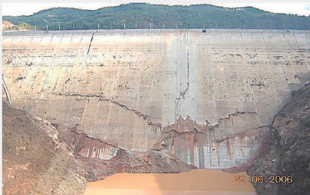
Figura 1.25 – Vista da face de concreto da barragem da UHE Campos Novos (SC) após o esvaziamento rápido do reservatório (Xavier & Correa, 2008)
