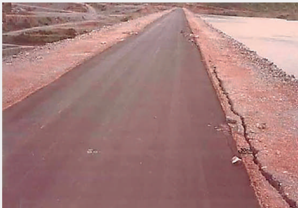
Figura 1.21 – UHE Emborcação: trinca longitudinal ao longo do paramento de montante (Divino, 2010)
