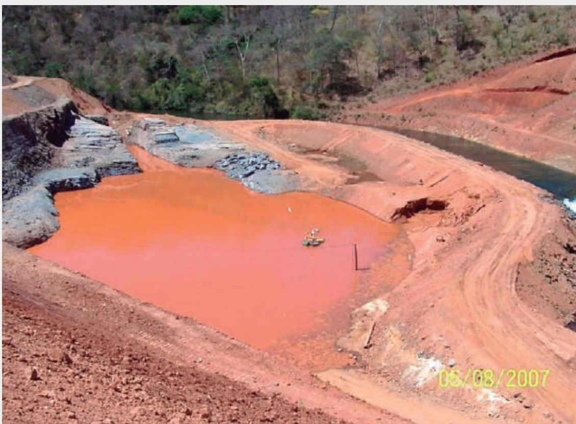
Figura 1.15 – Na PCH Areia o rompimento da ensecadeira ocorreu pela erosão de um bolsão de areia e detritos que havia permanecido na fundação (Foto dos autores, agosto de 2007)
