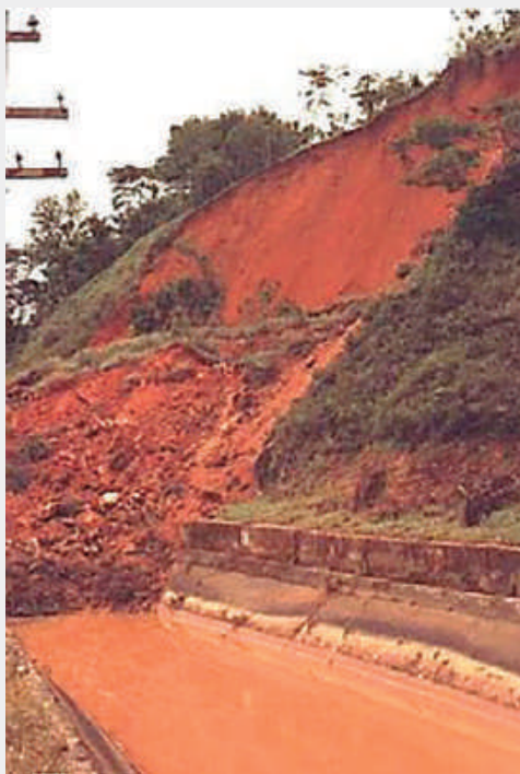
Figura 1.32 – UHE Joasal (MG): escorregamento em corte aberto para implantação do canal de adução da usina (Oliveira, 2008)
