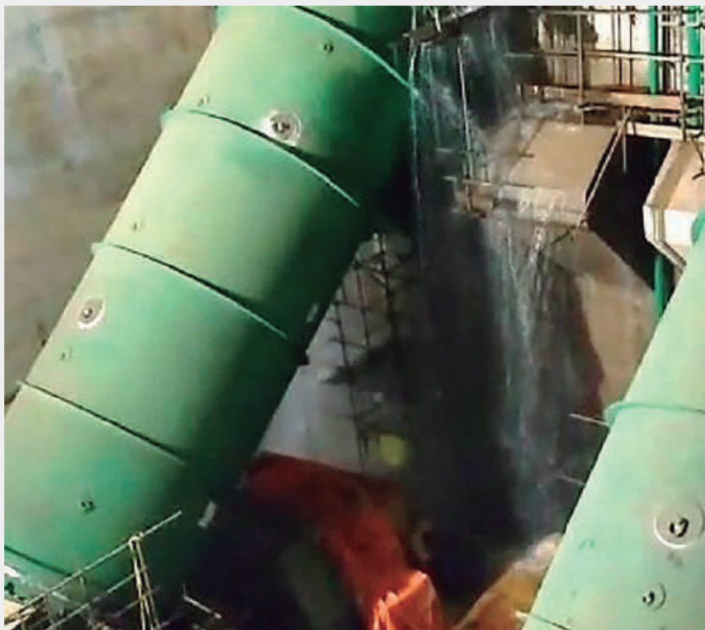
Figura 1.42 – PCH Verde 4, no rio Verde (MS): um forte vazamento devido aos problemas de vedação da comporta vagão da tomada d'água causou a inundação da casa de força (Internet)
