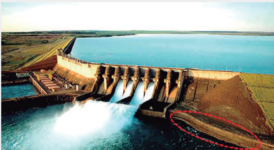
Figura 1.50 – UHE Água Vermelha: vista parcial após o reparo realizado no encontro do vertedouro com a margem esquerda (área assinalada), onde correntes de retorno causaram erosão no pé do enrocamento (Internet)
