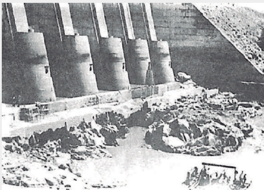
Figura 1.52 – UHE Moxotó (Apolônio Sales) – Erosão sobre rocha (Souza & Souza, 1992)
