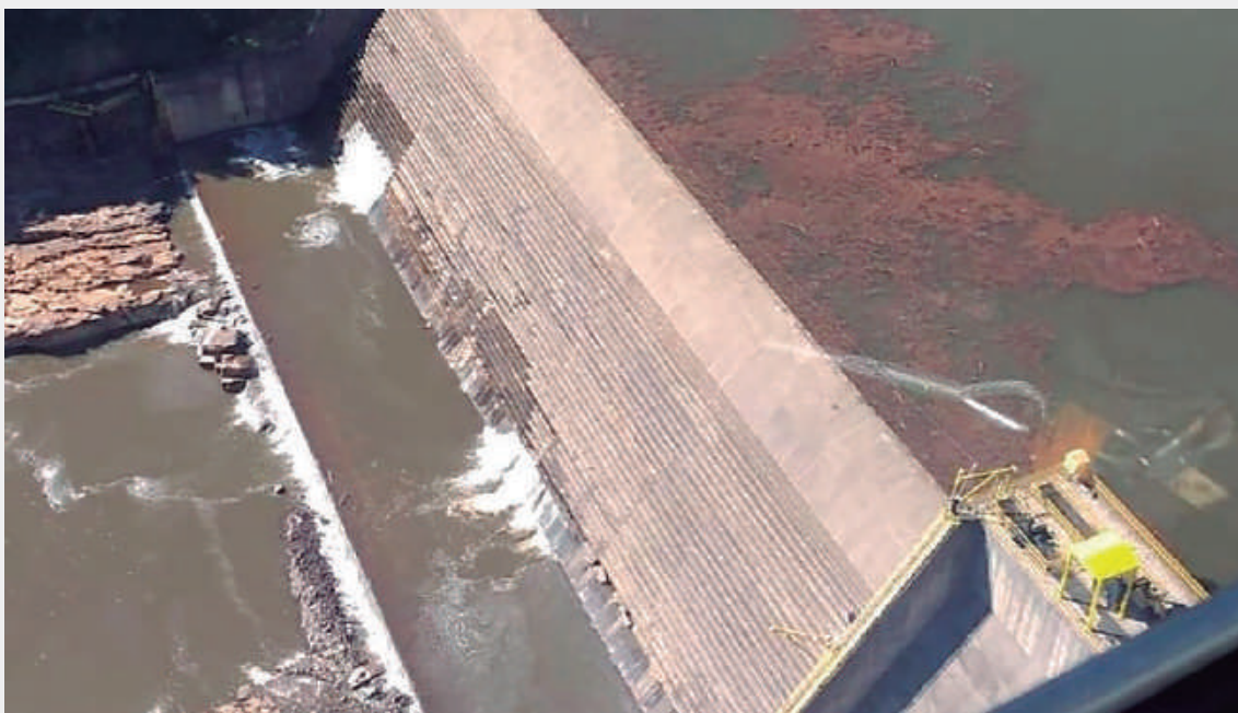
Figura 1.27 – Fortes surgências com alinhamento horizontal no paramento de jusante da barragem da PCH Passo do Meio (CREA-RS, 2020)
