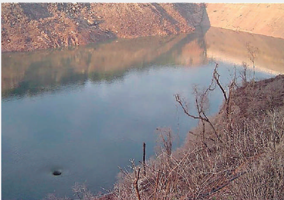
Figura 1.39 – UHE Campos Novos (RS): o redemoinho (vórtice) na superfície da água sinaliza o avanço do processo de esvaziamento do reservatório após rompimento no túnel de desvio n° 2 (Xavier, 2009)
