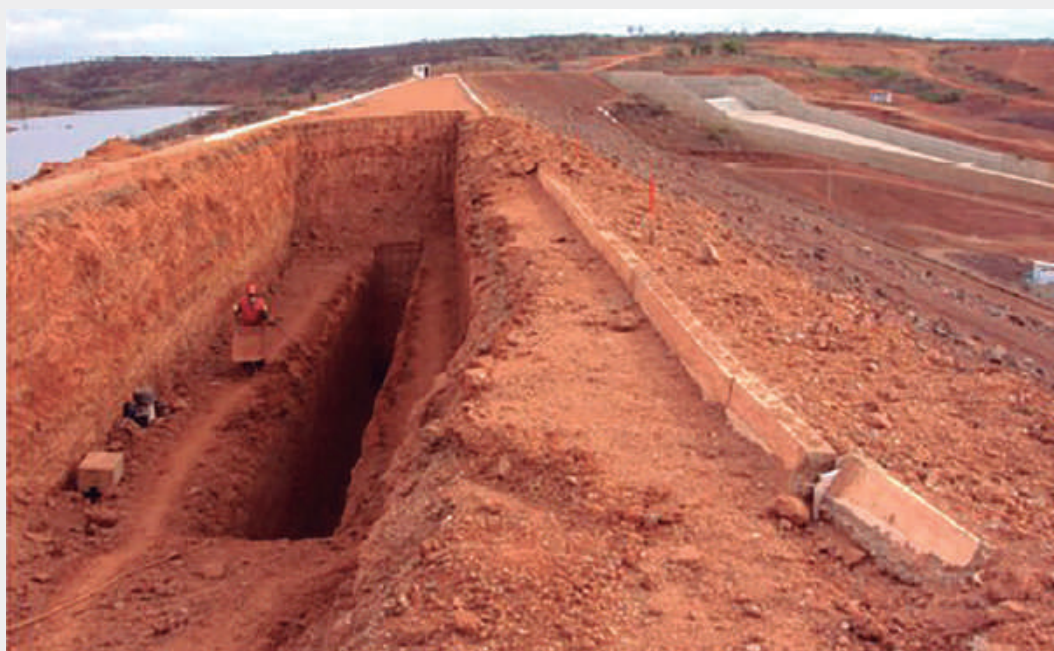
Figura 1.22 – Barragem de Piau (PI): trabalhos para correção de trincas transversais na ombreira direita (Miranda & outros, 2011)
