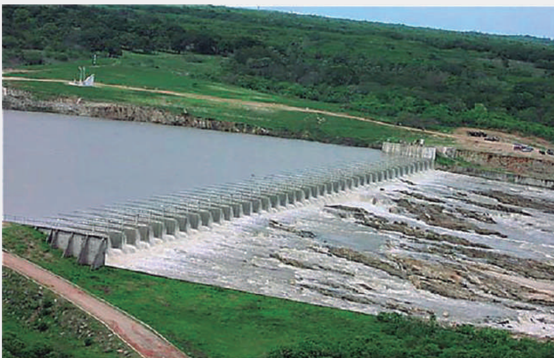
Figura 1.51 – Vertedouro em labirinto da barragem de Pacajus (CE). Sem elementos de proteção da rocha, a erosão regressiva alcançou a base da estrutura, colocando em risco sua integridade. Notar a erosão diferencial ao longo de faixas de menor resistência à ação das águas (Fontanelle & outros, 2007)
