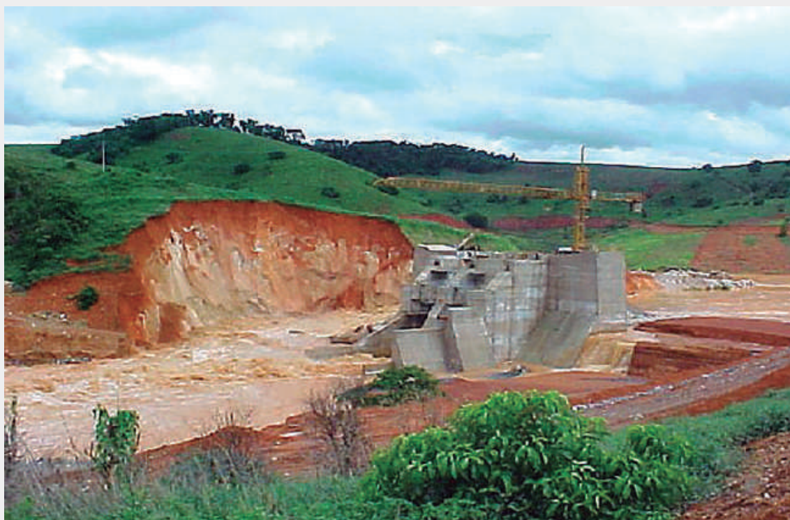
Figura 1.20 – Galgamento e destruição da margem direita da PCH Granada no rio Matipó (MG) (Almeida, 2004)
