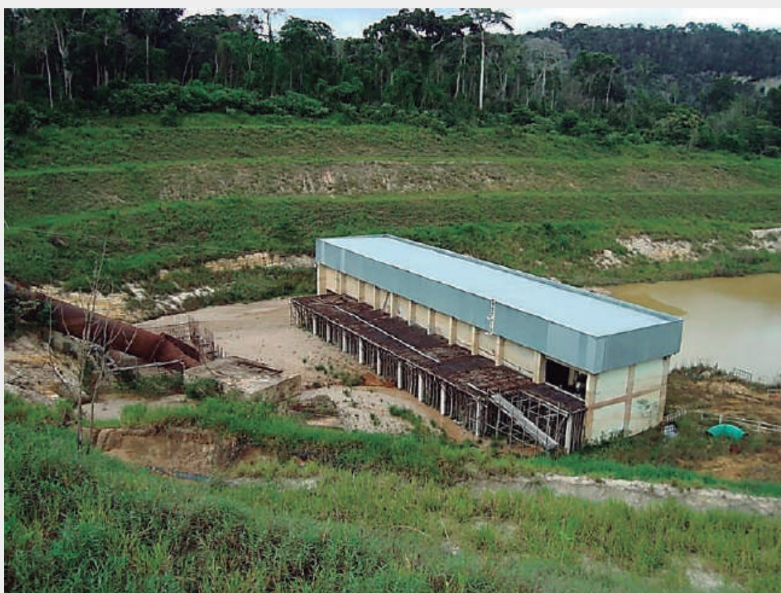
Figura 1.40 – A casa de força da PCH Apertadinho foi seriamente danificada pela onda de cheia que se propagou para jusante após o colapso da barragem (Foto de Paulo Levis)
