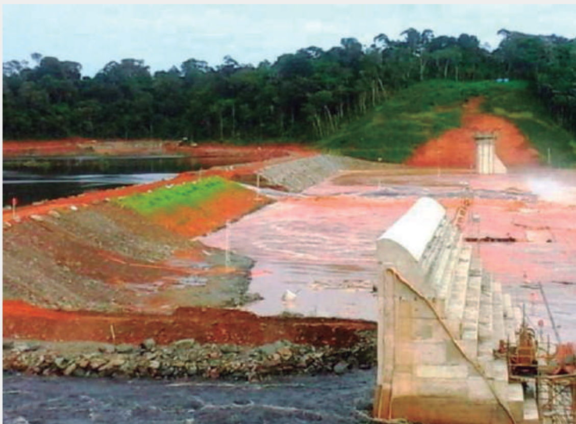
Figura 1.14 – Vista da brecha na ensecadeira de segunda fase, margem esquerda do rio Araguari (Internet)
