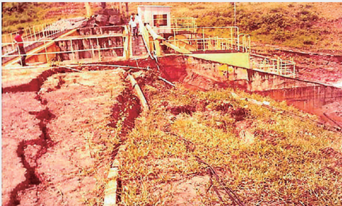
Figura 1.24 - Rompimento da barragem de Santa Helena em andamento. O processo teve início na base da estrutura de concreto do vertedouro (Amorim, 2016)
