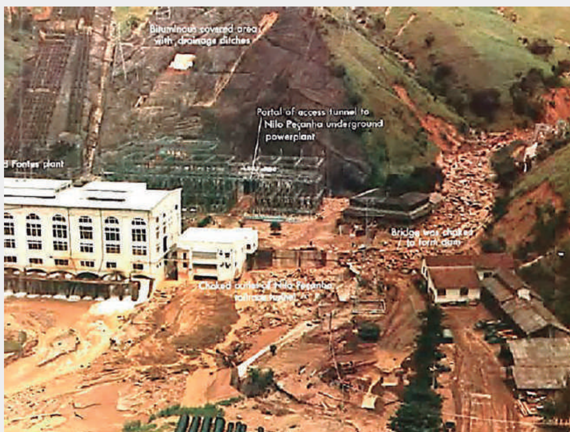
Figura 1.41 – Complexo da Light no pé da Serra das Araras: as estruturas das UHEs Nilo Peçanha e Fontes (o edifício branco do lado esquerdo) foram atingidas por escorregamentos e corridas de lama e detritos (Jones, 1973)
