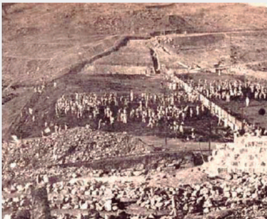
Figura 1.9 – Construção do aterro do açude Lima Campos por compactação manual e pisoteamento (DNOCS, 1982)
