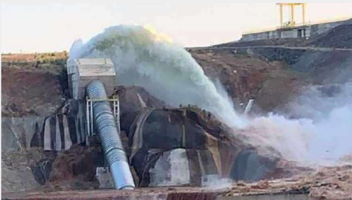
Figura 1.35 – Rompimento do conduto forçado de baixa pressão na barragem de Jati (CE) (Internet)
