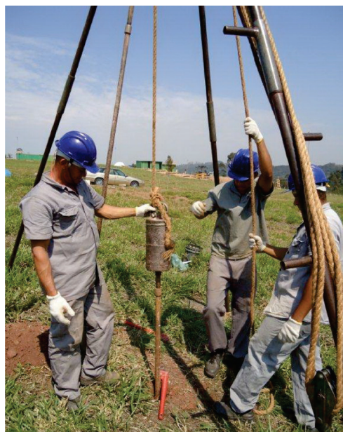
Sondagem a percussão: ensaio SPT – cravação manual.
