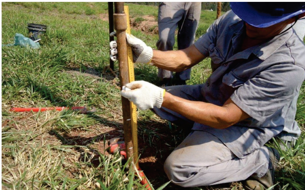
Sondagem a percussão: ensaio SPT – marcação dos trechos de 15 cm na haste.
