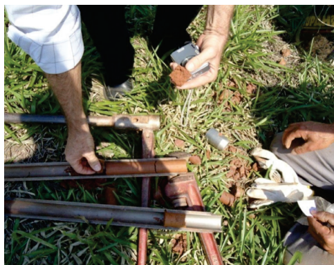
Sondagem a percussão: abertura do amostrador SPT.
