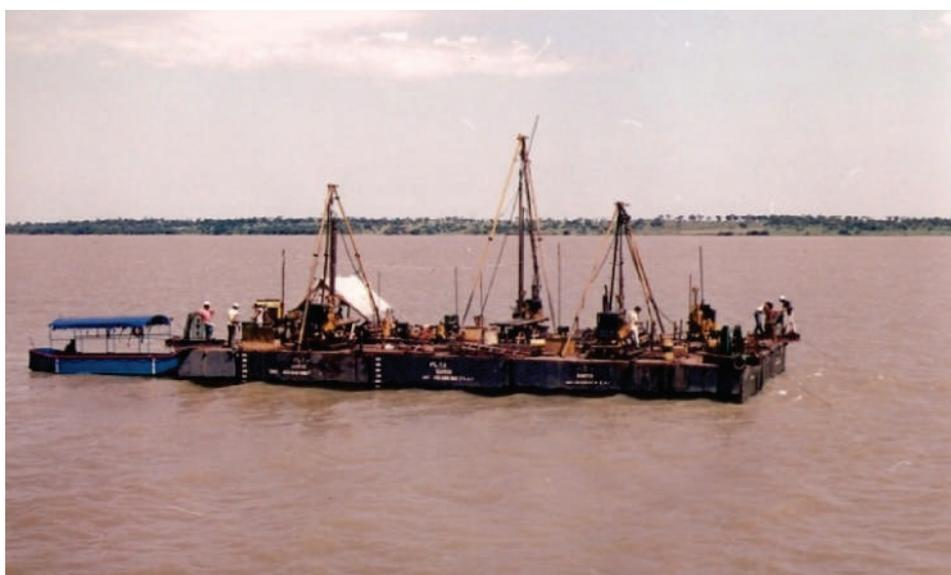
**Figura 34** – Sondagem rotativa em balsa no Rio Paraná.
