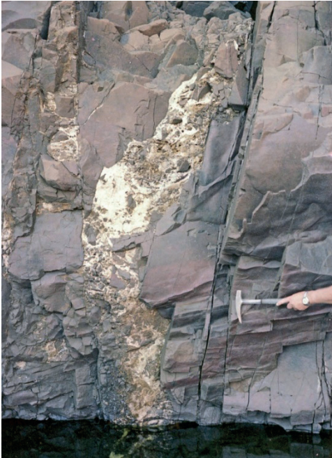
Figura 11.30.5 – Salto Santiago – Caixa de falha observada nas escavações.
