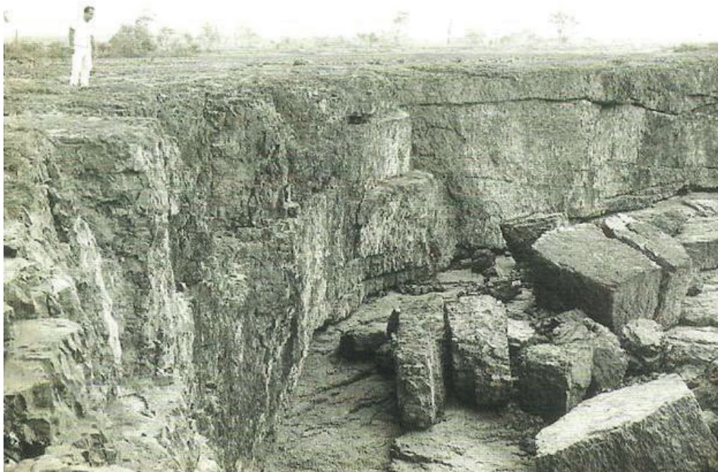
Figura 11.4.3 - Cachoeira Dourada – Escalonamento do maciço rochoso no leito do rio após ensecamento, condicionado por superfícies de juntas-falhas (ABGE, 2017).
