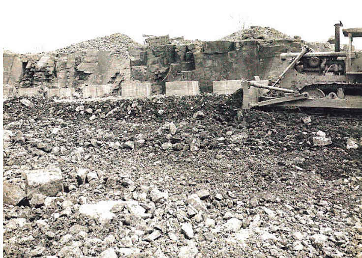
Figura 11.1.2.6 – Água Vermelha - Blocos para ensaios de aderência rocha-concreto (Fujimura, 2017).
