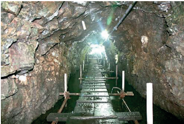
Figura 11.1.2.3 - Água Vermelha - Túnel de prospecção (Foto: Francesco Barale, in Curti, 2011).
