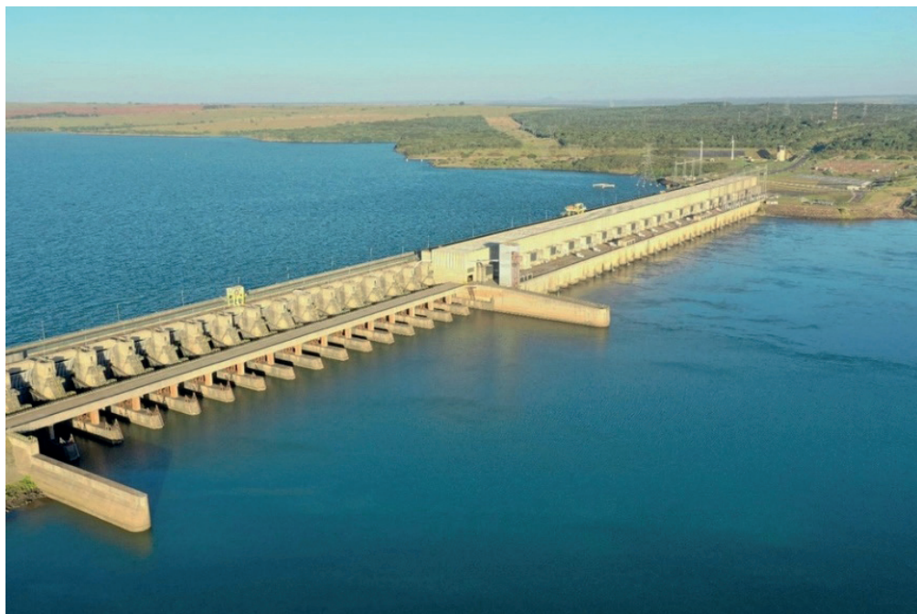
Figura 11.25.1 - Porto Primavera - Estruturas de concreto (internet - Foto Nova News).
