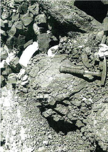
Figura 11.16.2.3 – Jupuíá - Desagregação de rocha basáltica submetida às intempéries (Foto de J.A. Miotto, 1968).
