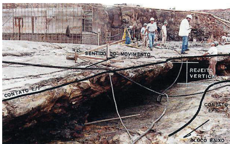
Figura 11.6.4 - Canoas I - Aspecto da zona focal da falha (Foto Magalhães, in ABGE, 2018).
