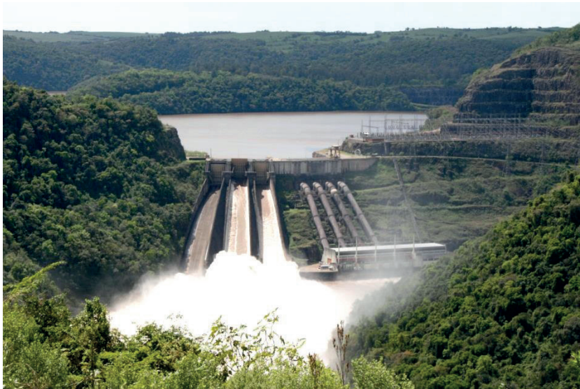
Figura 11.15.1 - Itaúba – Arranjo das estruturas de concreto (internet).
