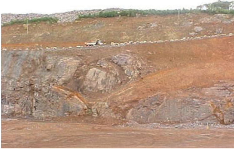
Figura 11.5.3 - Campos Novos - Exposição do derrame F no canal de aproximação (dacito, riolito) (Cordel & Tajima, 2005).
