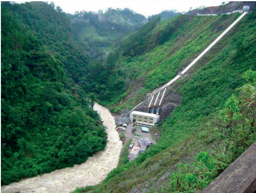
Figura 11.24.1 – Passo Fundo – Casa de força no rio Erechim (internet - https://www.vemprefabrica.com.br/empresa/usina-hidreletrica-passo-fundo ).
