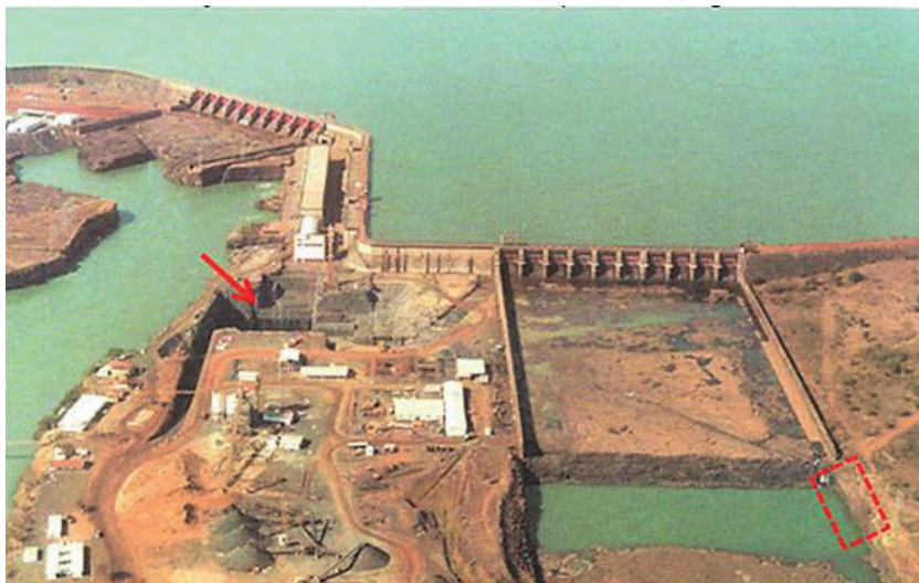
Figura 11.4.1 – Cachoeira Dourada - Vista aérea – A seta assinala a escavação para a quarta etapa de motorização. Do lado direito da imagem, a figura indica a parede em cuja fundação foi observado o túnel de lava (CBDB, 2002).
