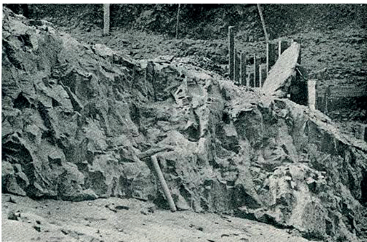
Figura 11.2.3 - Bariri - Eclusa - As leptoclases no basalto denso são subordinadas ao sistema de diaclases (Bagolini & Guidicini, 1964).
