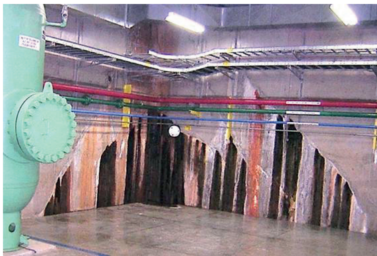
Figura 11.23.7 - Nova Ponte - Quina montante esquerda da casa de força na el. 699,40 m (Brito, S. - Comunicação pessoal).
