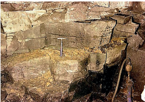
Figura 11.14.4 - Itaipu - Aspecto de junta-falha inserida em maciço basáltico de rocha sã (Itaipu Binacional, 1982).
