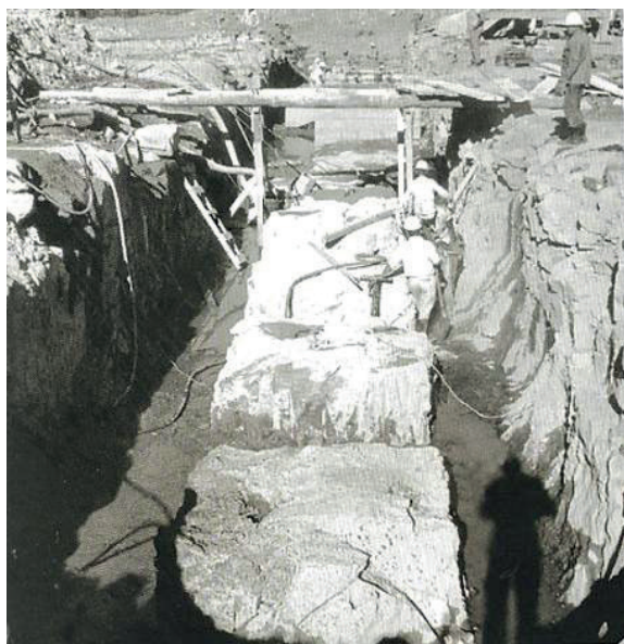
Figura 11.12.1.7 - Ilha Solteira - Preparação de blocos de 2 x 2 metros para os ensaios de resistência ao cisalhamento (ABGE, 2017, pág. 53).
