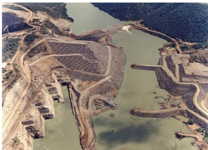
Fig. 3.37 – UHE Xingó. 2ª Fase de desvio.
