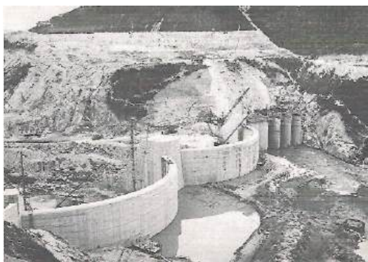
Fig. 3.55 – UHE Funil. Ensecadeira de montante ( H=20 \text{ m} ) e vertedouro margem direita.
