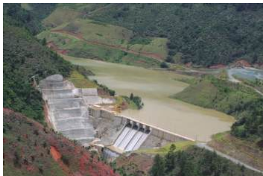
Fig. 3.63 A – UHE Pinalito. Barragem principal e vertedouro. (Internet).
