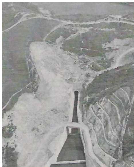
Fig.3.50 I – UHE Funil. Vista de jusante após primeiro enchimento. Vertedouro de fundo margem esquerda – Lbacia = 45 m; túnel de desvio: D=11,50 m.
