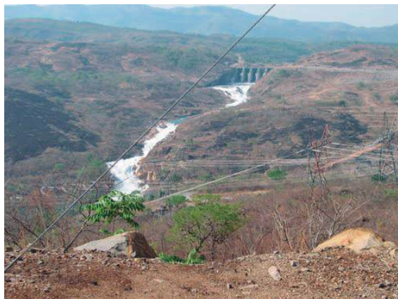
Fig. 3.45 – Vertedouro da UHE Serra da Mesa operando. (Internet). Observar o escoamento restituído por sobre o maciço rochoso a jusante.
