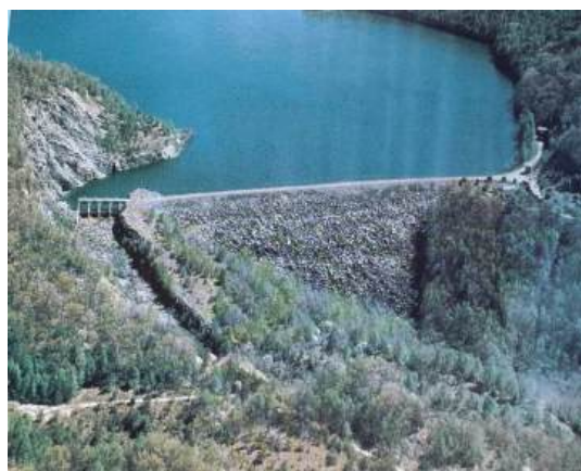
Fig. 3.100 – UHE Nantahala. Barragem de enrocamento e Vertedouro. Emboque da TA na ombreira esquerda. Vista de Jusante.
