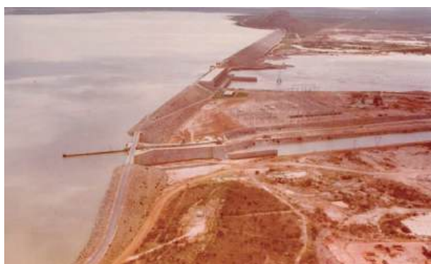
Fig. 3.29 – UHE Sobradinho. Vista da margem direita. Barragem MD, eclusa, barragem central/subestação, TA/CF, vertedouros, barragem ME.
