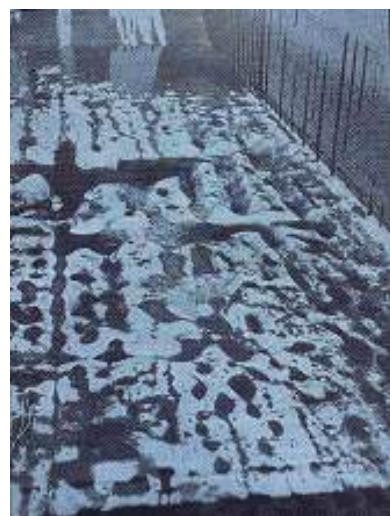
Fig. 3.118 – UHE Dworshak. Erosão da bacia de dissipação.
