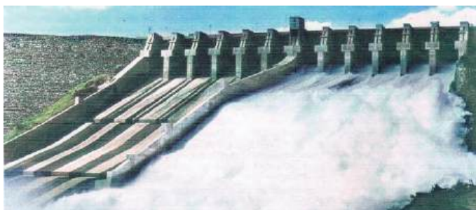
Fig. 3.39 – UHE Xingó. Vertedouro de emergência.
