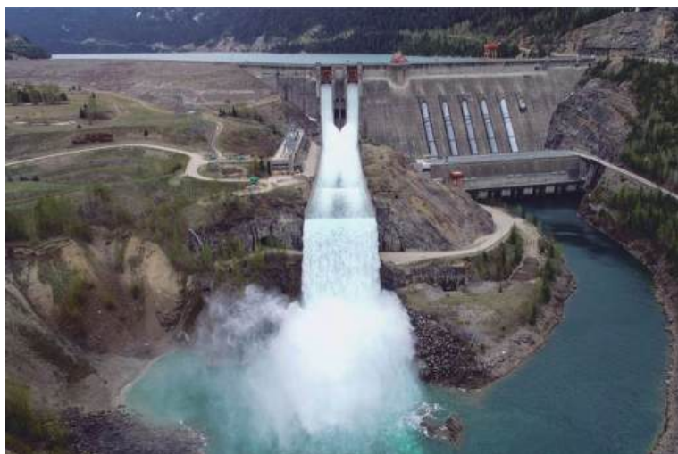
Fig. 3.144 – UHE Revelstoke. Vista de jusante - vertedouro operando.
