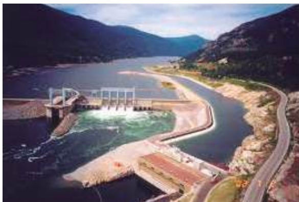
Fig. 3.146 – UHE Keenleyside. Vista de jusante da eclusa, vertedouro e da casa de força.
