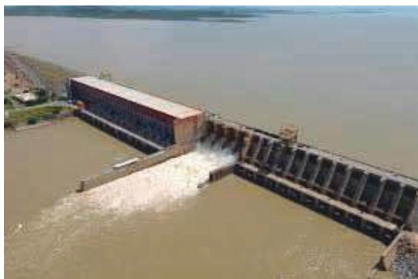
Fig. 3.28 – UHE Sobradinho. Estruturas de concreto, vertedouro de fundo, vertedouro de superfície em funcionamento, e casa de força. Ao fundo, barragem da margem direita.
