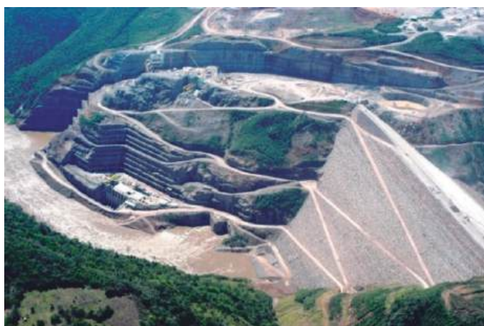
Fig. 3.56 B – UHE Campos Novos. Rio desviado por túneis na margem direita. Casa de força ensecada. Ao fundo vertedouro em obras.
