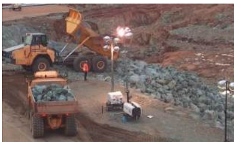
Fig. 3.90 – Oroville. Recuperação da erosão a jusante do vertedouro de emergência.
