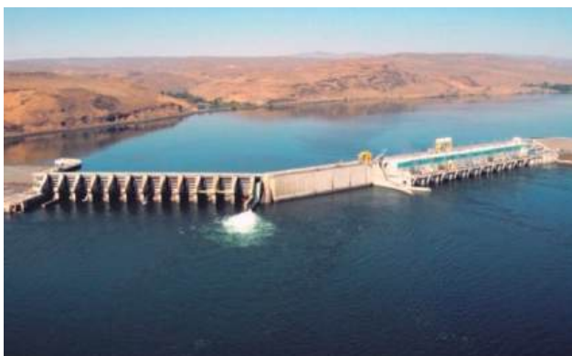
Fig. 3.109 B – UHE Wanapun. Vertedouro e Casa de Força.
