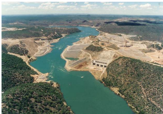
Fig. 3.36 – UHE Xingó. 1ª Fase de desvio.
