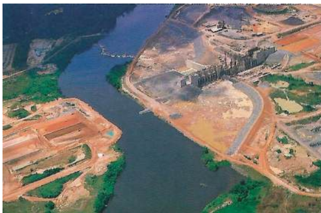
Fig. 3.17 – UHE Balbina – 1ª fase de desvio.
