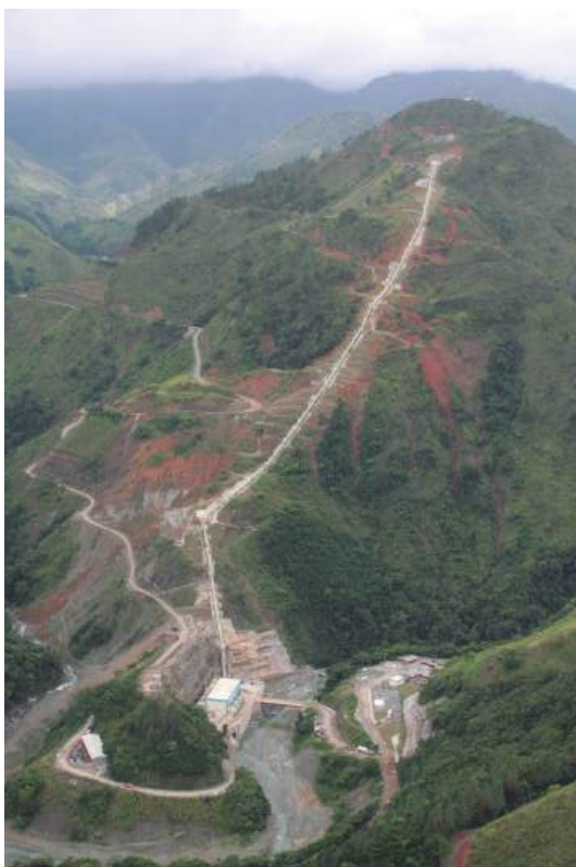
Fig. 3.63 C – UHE Pinalito. Vista aérea do conduto forçado e casa de força (Internet).
