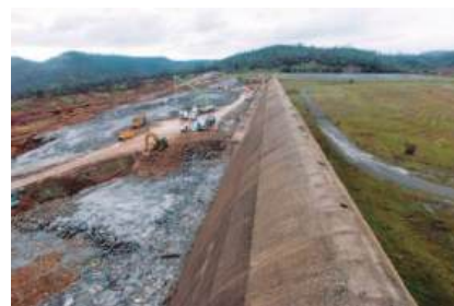
Fig. 3.90 – Oroville. Recuperação da erosão a jusante do vertedouro de emergência.
