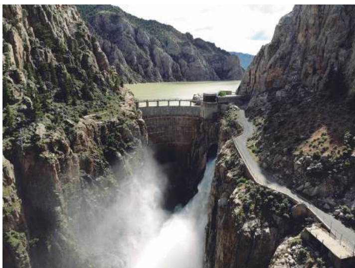
Fig. 3.74 B – UHE Buffalo Bill. Vista de Jusante. Descarregador de fundo funcionando - 1957.
