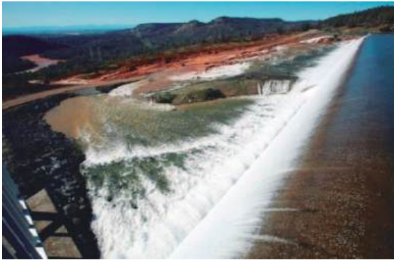
Fig. 3.89 – Oroville. Incidente. A - ruptura da calha; B - vista da calha rompida; C - vertedouro de emergência funcionando.
