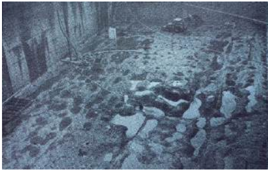
Fig. 3.120 – UHE Libby. Abrasão na bacia de dissipação (Neidert, 1979).
