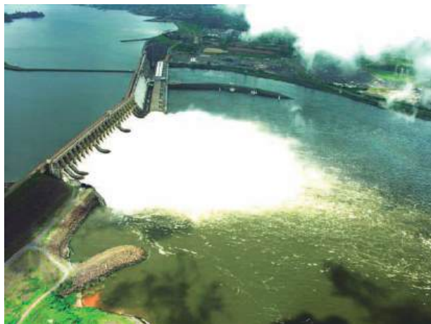
Fig. 3.23 – UHE Tucuruí – Vista aérea de jusante. Barragem do canal central, parcial, vertedouro, casas de força I e II e barragem de ligação/eclusa. (Eng. Álvaro Lima de Araújo, ELN).
