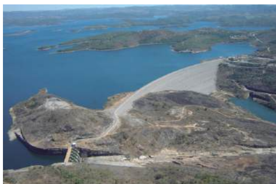
Fig. 3.44 – UHE Serra da Mesa Vista da margem direita. Em primeiro plano vertedouro com uma pequena laje de concreto; o resto da calha é sobre o maciço rochoso.
