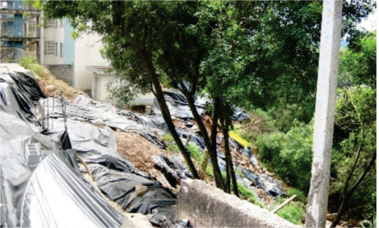
Figura 8. Conjunto Residencial da CDHU construído em cabeceira de grotá contribuiu com a reativação de sua dinâmica evolutiva, Franco da Rocha, SP. Fonte: Foto do autor.
