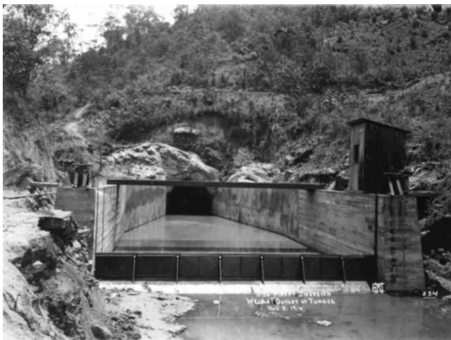
Figura 8. Emboque de jusante do túnel de Tócos.
