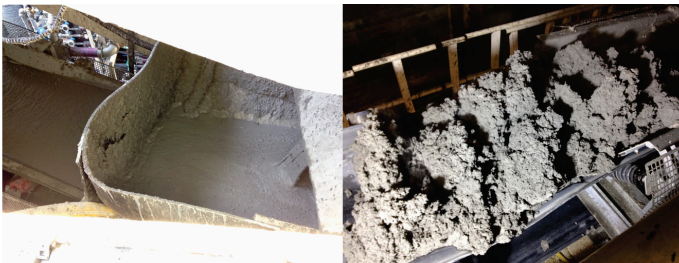
Figura 2. Consistências inadequadas do muck: esquerda muito líquido, direita muito rígido.
