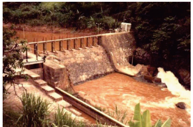
Figura 4. Usina Marmelos Zero. Detalhe do barramento vertente.
