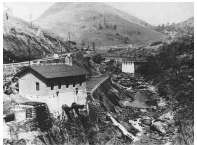
Figura 3. Usina Marmelos Zero. Vista geral de jusante para montante com casa de força em primeiro plano e barramento vertente ao fundo.
