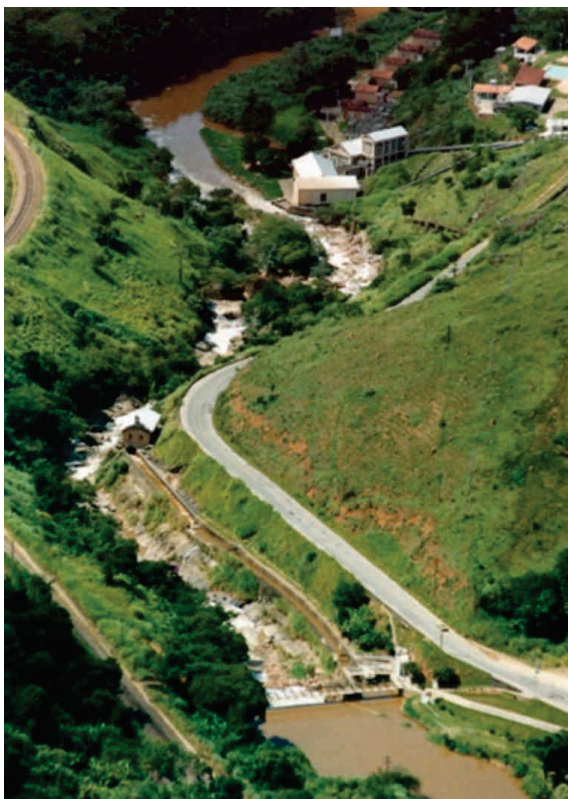
Figura 2. Usina Marmelos Zero. Vista aérea do reservatório com a BR-040 à direita.
