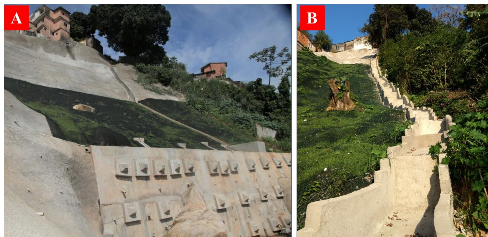
Figura 7. Fotos obtidas entre 2020 e 2021 mostram exemplos de obras de estabilização já finalizadas em Santos: A, na Rua Santa Marta, Morro São Bento, e, B, entre as ruas 1 e 8, nos morros Pacheco e Penha.
