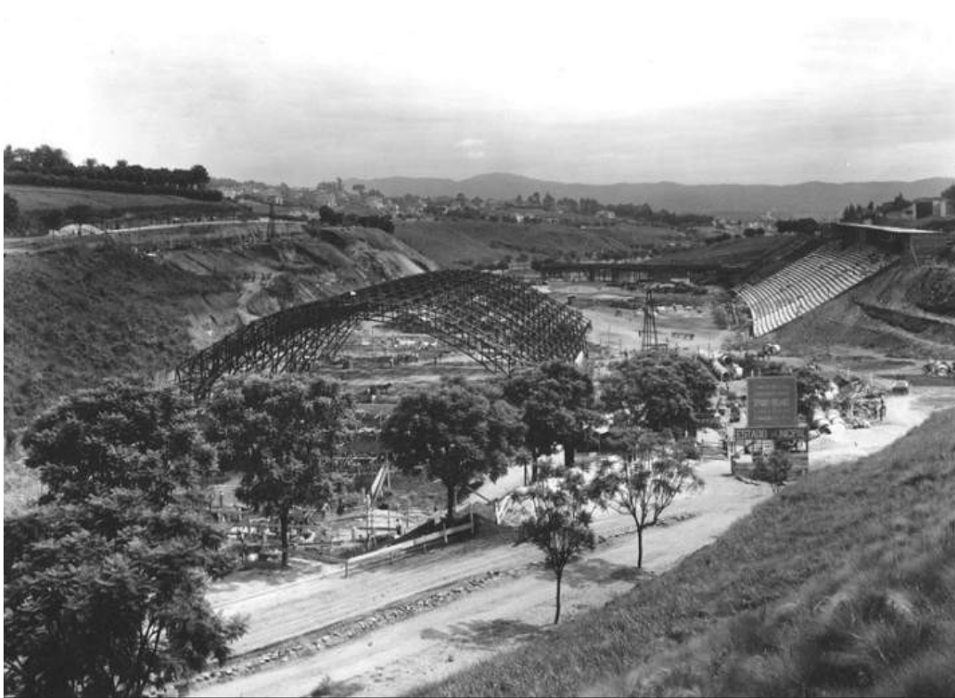
Figura 9. Foto panorâmica mostrando o avanço das obras do estádio, identificando-se a estrutura da cobertura do ginásio e a arquibancada lateral direita já assentada sobre o talude da gruta. Ao fundo, a Serra da Cantareira.
