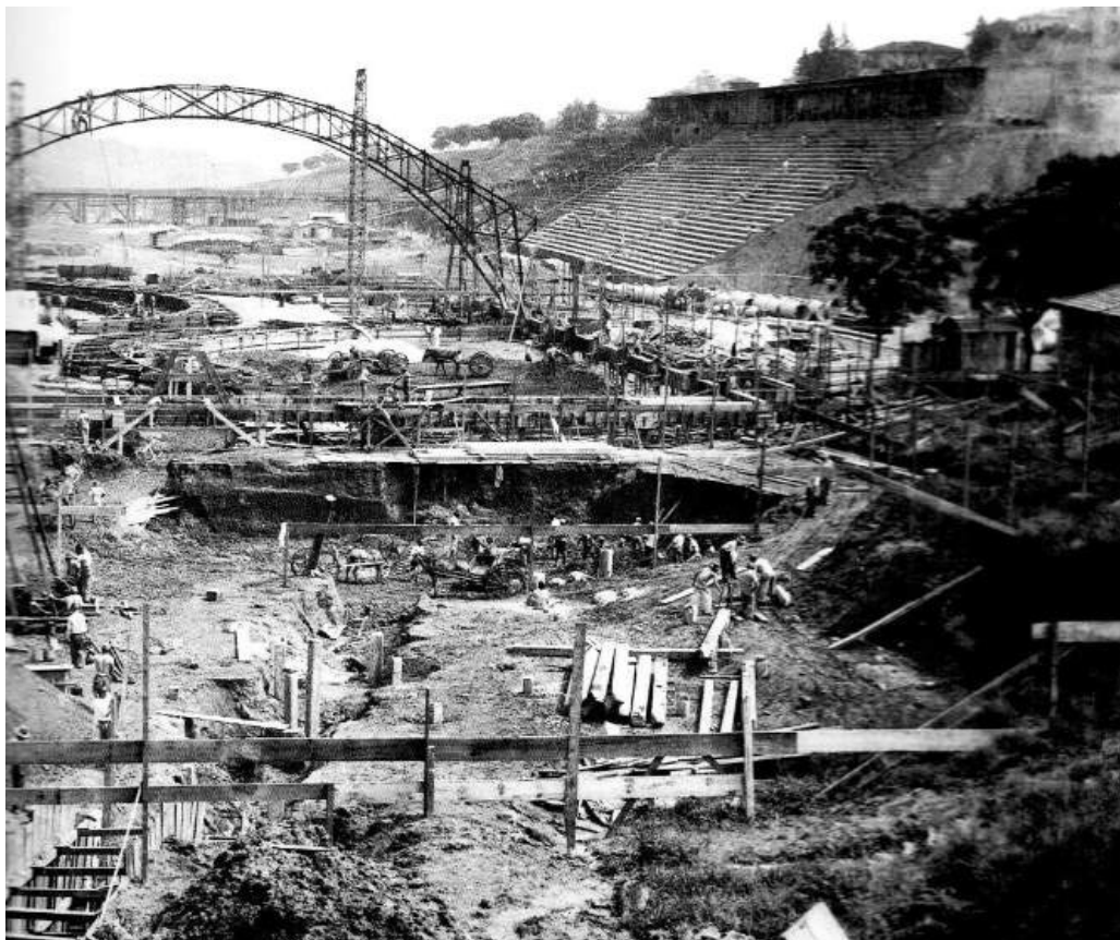
Figura 8. Detalhe do canteiro de obras.
