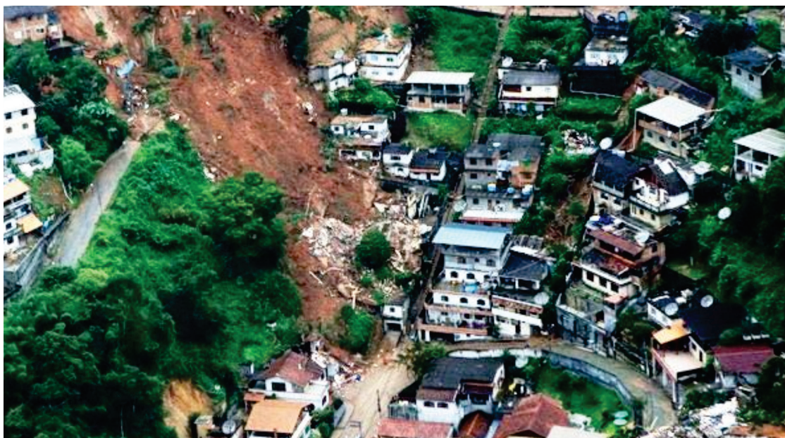
Figura 4. Grota com densa urbanização. Nova Friburgo RJ. Fonte: Foto HCMiranda.
