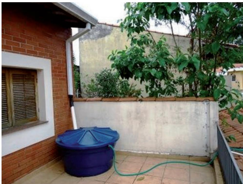
**Figura 13** - Uma outra instalação para acumulação e uso de águas de chuva incidentes sobre telhados.
