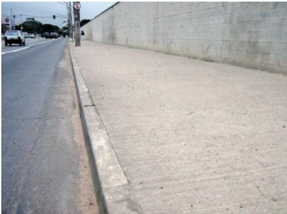
**Figura 15** - Exemplo com sarjeta e calçada totalmente impermeáveis.
