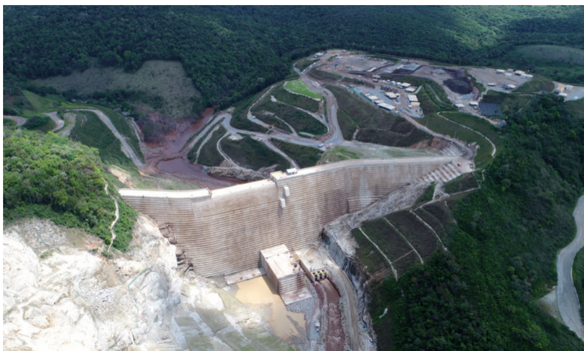
Figura 7 - Imagem aérea obtida por drone da ECJ de Mina Fábrica, agosto de 2021.
