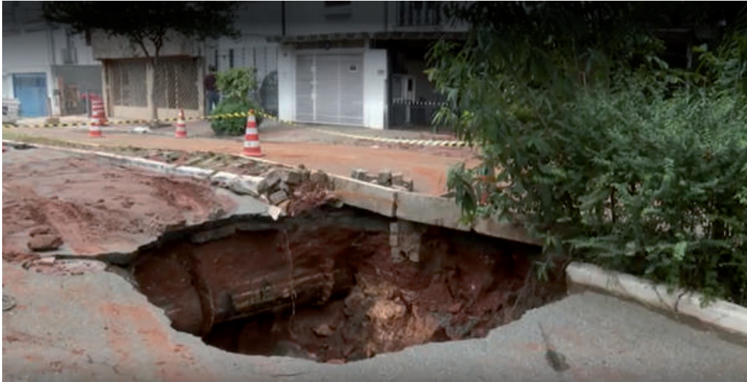
Figura 2 – Vista de cavidade aberta em via pública. Fonte: Portal G1 (2020). Data de publicação da matéria: 07/12/2020.
