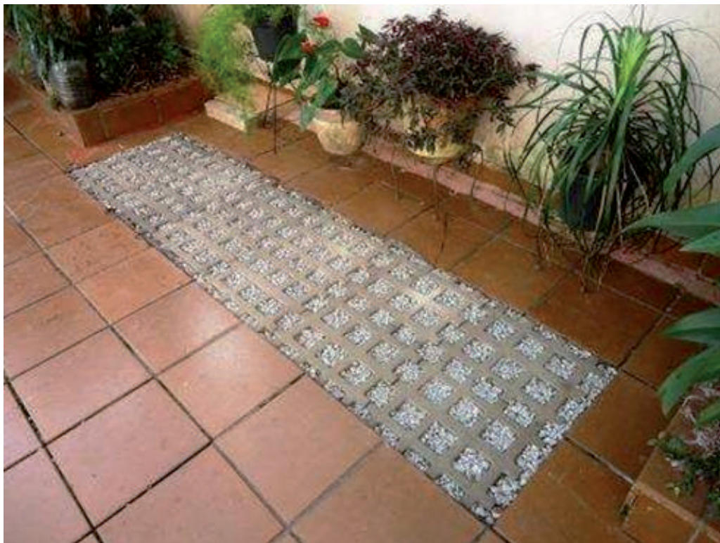
Figura 11 - Foto de um dispositivo doméstico de acumulação/infiltração já instalado em plena operação.
