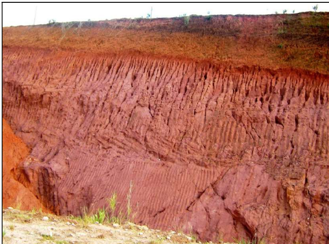
Perfeita distinção entre a camada superficial, com solos mais argilosos e laterizados, e o solo de alteração mais profundo, silto-arenoso, extremamente erodível. Terrenos cristalinos. Foto ARSantos.
