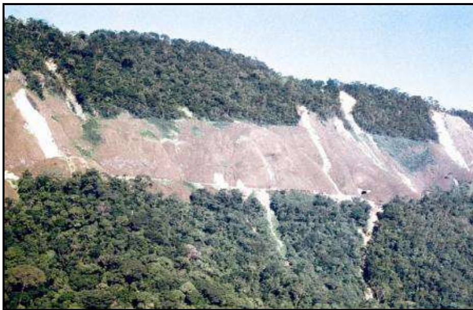
Erro idêntico cometido pela engenharia brasileira no trecho Serra do Mar da Estrada de Ferro Sorocabana. Notar os inúmeros deslizamentos associados a esse desmatamento.
