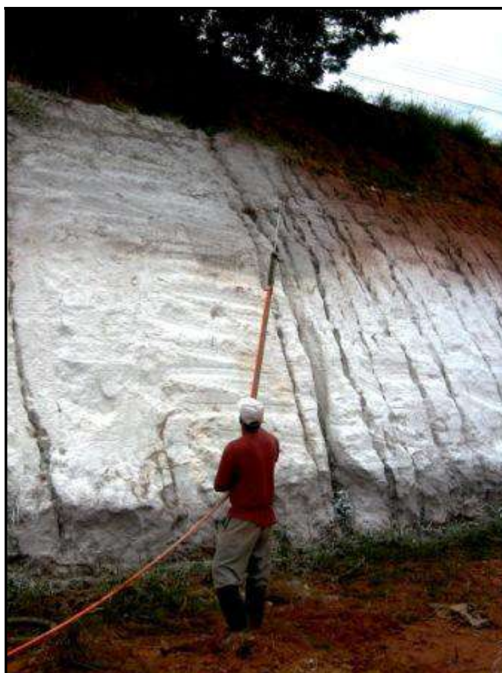
Lança presa em haste de madeira: expediente para se alcançar alturas maiores
