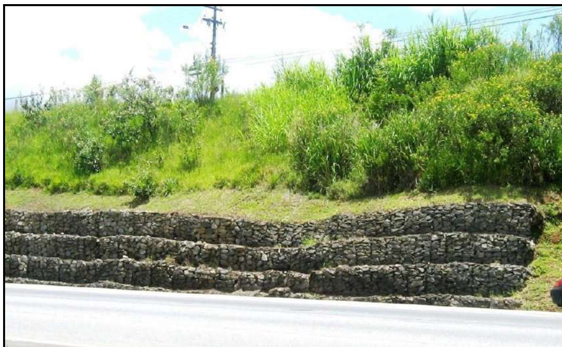
Gabiões: excelente solução de muro de gravidade autodrenante. Admite deformações de acomodamento sem perda da funcionalidade. Atualmente se faz necessário um esforço tecnológico de barateamento da gaiola de arame galvanizado ou plastificado, assim como, quando disponível, o uso de entulho de construção civil em vez de pedra graduada. (Foto do Autor)
