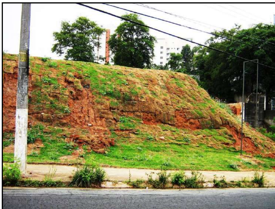
A grama em placa é uma ótima solução para proteção superficial, mas é uma proteção hoje relativamente cara, o que sugere mais cuidado em sua aplicação. Por exemplo, não vinga em taludes de declividade alta e não resolve absolutamente nada em caso de fenômenos de rupturas rasas ou profundas, como mostra a foto. (Foto do Autor)
