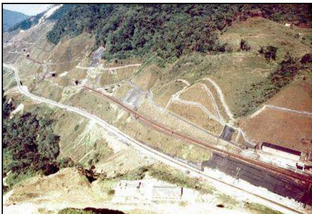
Enorme faixa desmatada a montante da ferrovia Santos Jundiaí na travessia da Serra do Mar. Erro grave cometido pelos ingleses ao imaginar que as árvores da floresta tropical poderiam potencializar deslizamentos. Ao contrário, foi esse desmatamento que induziu o enorme número de deslizamentos com que teve que conviver a ferrovia desde sua construção.
