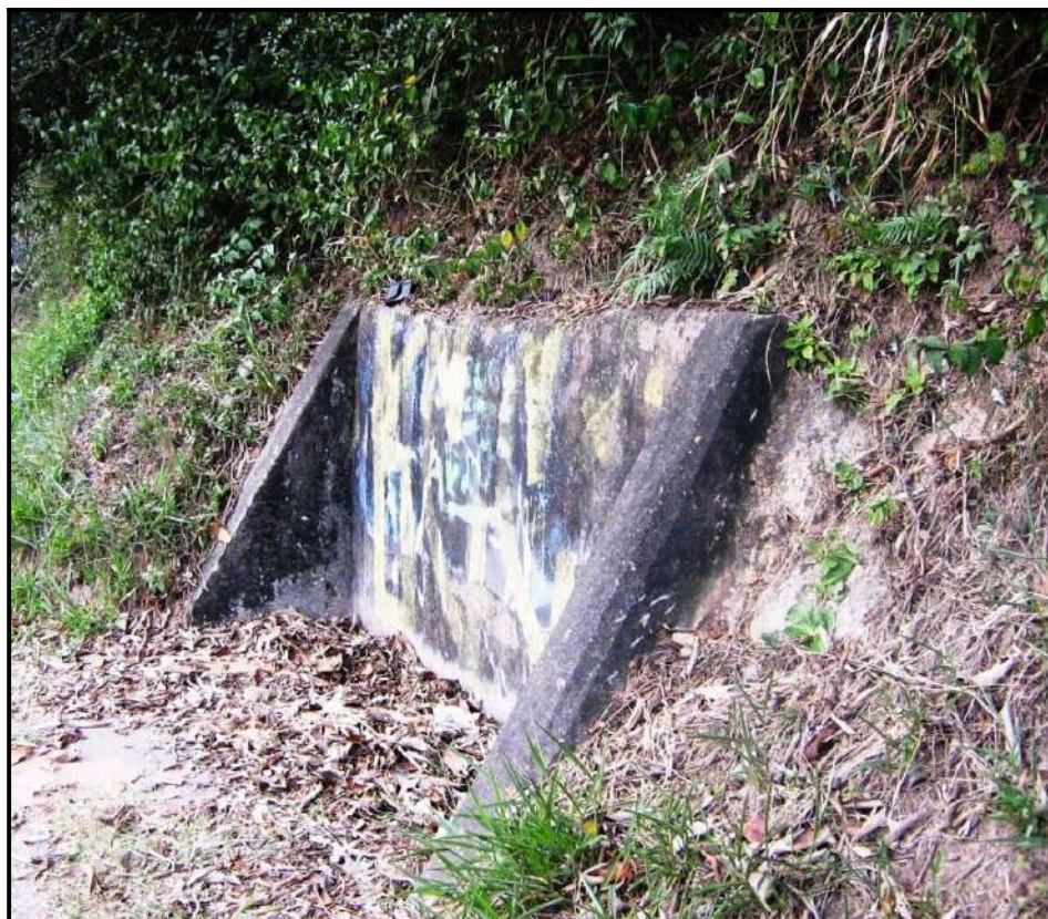
Pequena estrutura de arrimo de concreto com contrafortes. (Foto do Autor)
