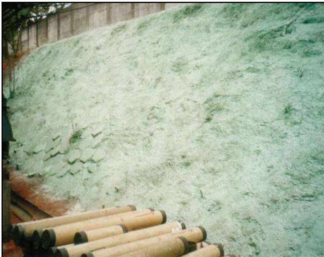
Proteção concluída com 2ª demão pigmentada
