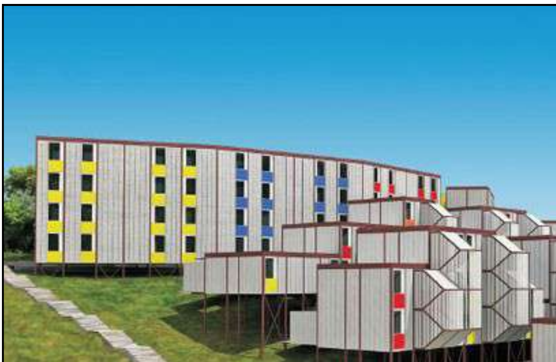
Projeto desenvolvido pelo arquiteto João Filgueiras Lima (Lelé) plenamente adequado (lajes sobre pilotis) a terrenos de média e alta declividade. Imagem Arq. JFL.
