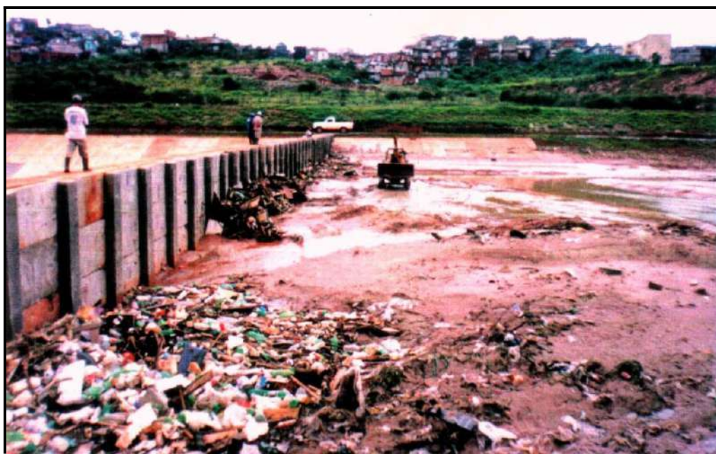
Interior de um piscinão: assoreamento de sedimentos e lixo difícilimo de se remover, além da alta contaminado pela poluição das águas superficiais da metrópole. (Foto do Autor)
