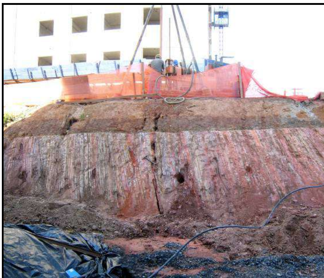
Notar a orientação praticamente vertical dos diversos estratos xistosos metamorfizados. A rocha calcária sã encontra-se em média de 30 – 80 metros de profundidade a partir desse nível. Foto ARSantos
