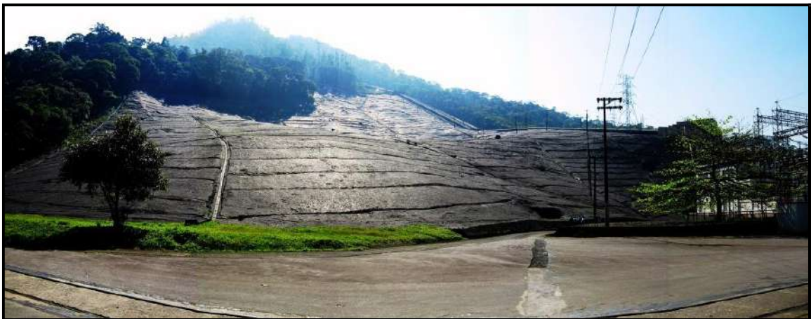
O grande corpo de tálus cuja movimentação ameaçou seriamente as instalações da Usina Elétrica Henry Borden foi trabalhosamente estabilizado via impermeabilização superficial e densa rede de drenagem subterrânea. (Foto do Autor)
