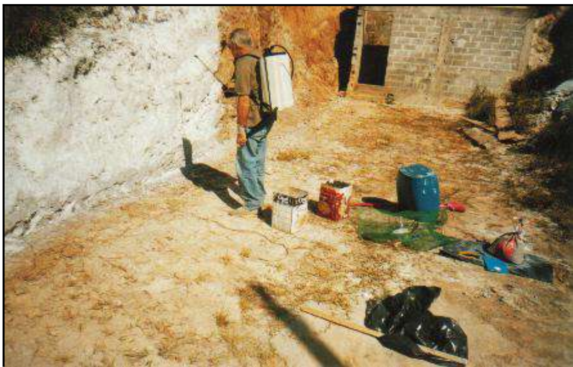
Executando a 1ª demão da pulverização com o pulverizador costal manual
