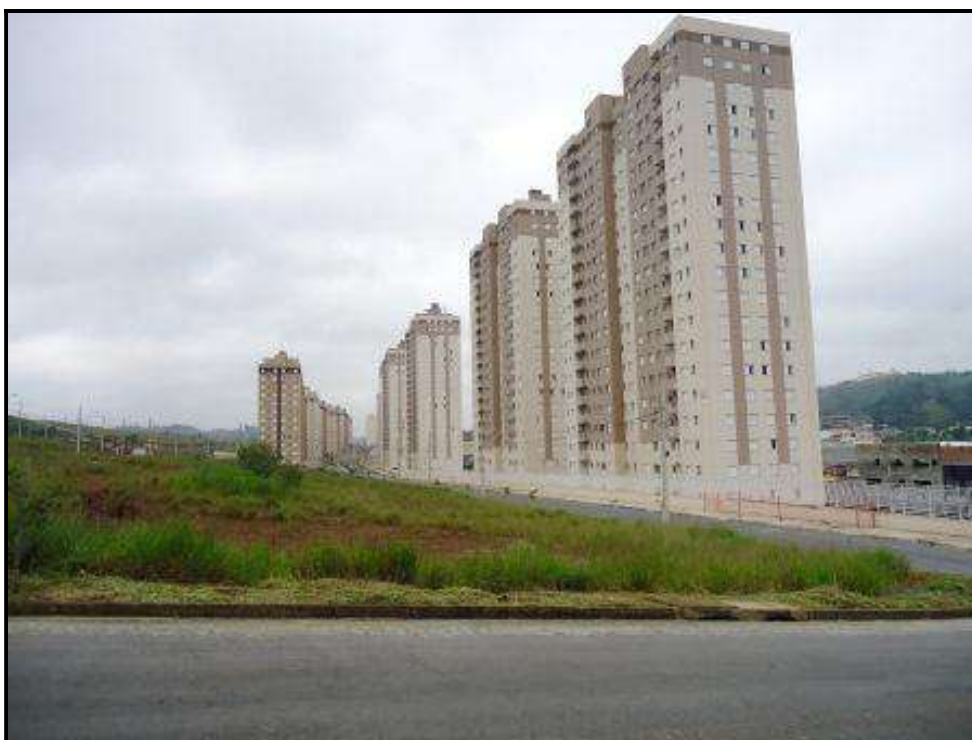
Grande empreendimento imobiliário que teve uma segunda fase avançando sobre a faixa do vale aí presente, coincidente com o alinhamento cárstico Polvilho - Natura, apresentado grande concentração de vazios na interface solo/rocha, o que veio a demandar extensivo tratamento geotécnico por injeções de calda de cimento e adoção de estacas hélice contínuas como sistema de fundação. Foto ARSantos.
