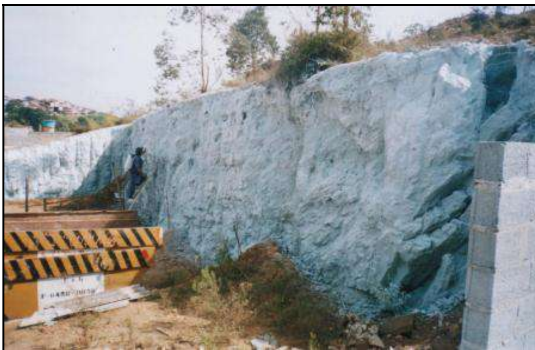
O mesmo talude após a proteção concluída
