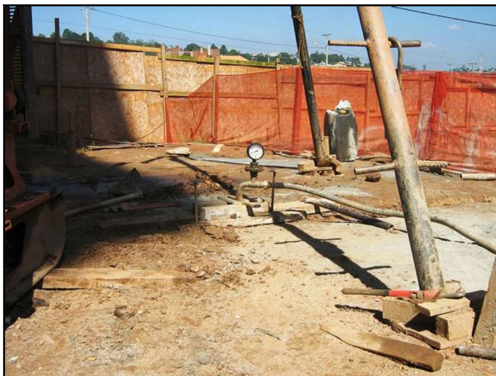
Ponto sendo injetado com controle de manômetro. Foto ARSantos.
