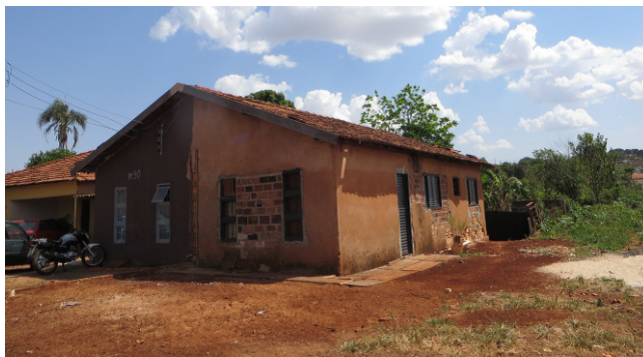
Figura 6. Local de atingimento por inundações na cidade de Jataí, onde em eventos a água podia alcançar 2,00 mts, 2015 (Melo et al, 2015).
