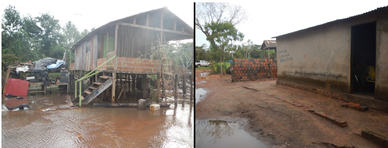
Figura 23. Residências atingidas por inundação provocadas pelo córrego Vilas Boas, Miranda, 2015(Lima et al, 2015).
