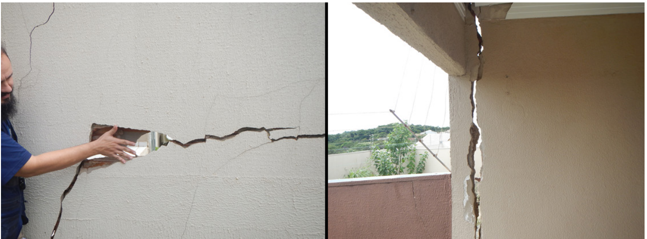
Figura 14. Local de movimentação de solo em situação de corte-aterro, Rua Doze, Bairro Morumbi, Anápolis, 2019 (Fernandes et al, 2019).
