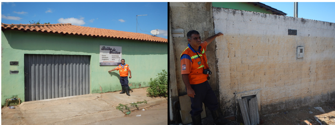
Figura 11. Locais atingidos por inundações em eventos de 2016, Goiânia, 2016 (Fernandes et al, 2016).
