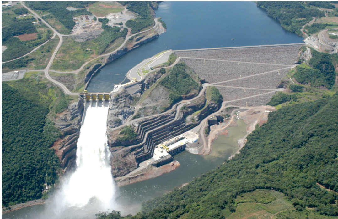
Figura 7. UHE Campos Novos – Arranjo com Circuito Adutor. Situa-se no rio Canoas, 21 km a montante da confluência com o rio Pelotas, e tem potência de 900 MW. A barragem, de enrocamento com face de concreto, tem 202 m de altura e 590 m de comprimento. O vertedouro tem 4 vãos de 17,4 m largura e 20 m altura. A capacidade de vazão é de 18.300 m 3 /s.
