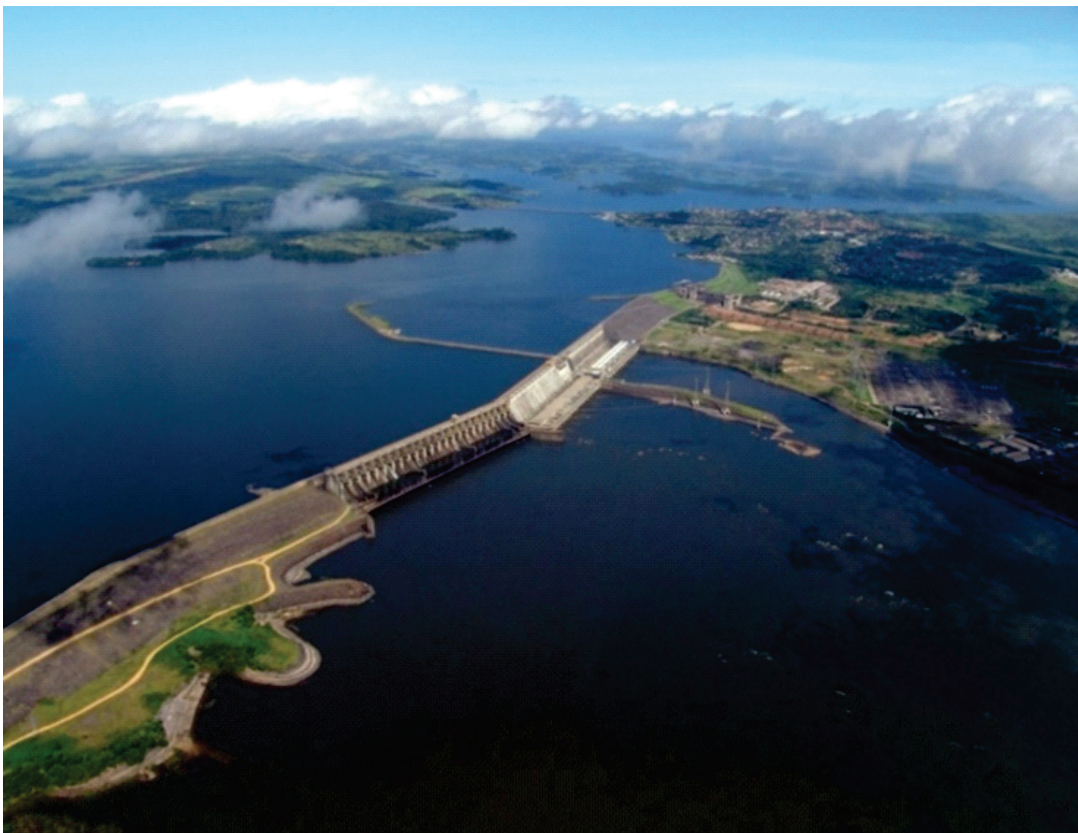
Figura 5. UHE Tucuruí – Arranjo Compacto. Situa-se no trecho baixo do rio Tocantins, no Estado do Pará, com potência de 8.125 MW. A barragem tem 95 m de altura e comprimento de 7 km. O vertedouro da usina, um dos maiores do mundo, tem 23 vãos de 20 m largura e 21 m altura e capacidade de vertimento (Q) de 110.000 m 3 /s.
