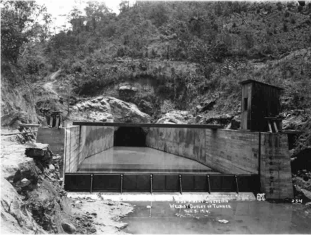
Figura 8. Emboque de jusante do túnel de Tócos.
