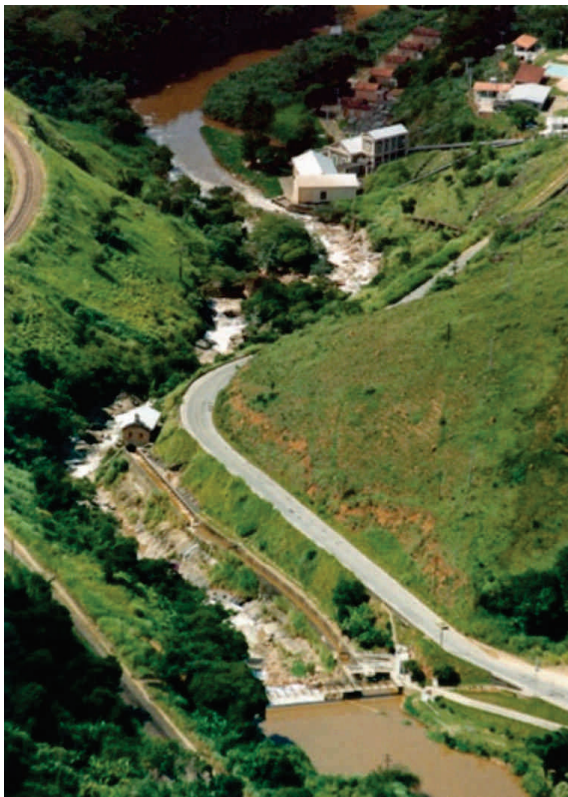
Figura 2. Usina Marmelos Zero. Vista aérea do reservatório com a BR-040 à direita.
