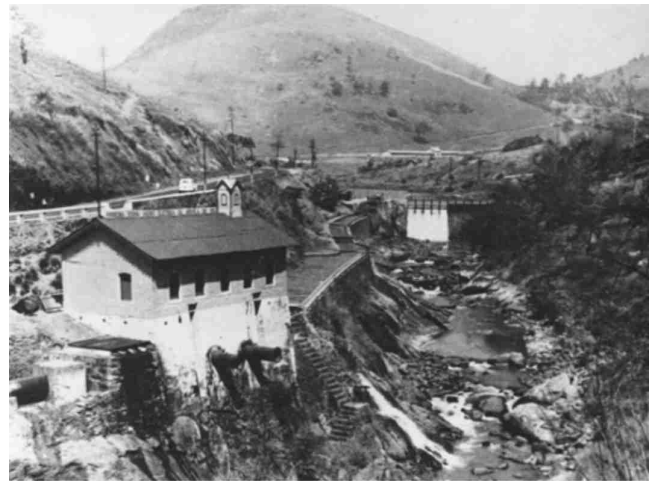
Figura 3. Usina Marmelos Zero. Vista geral de jusante para montante com casa de força em primeiro plano e barramento vertente ao fundo.
