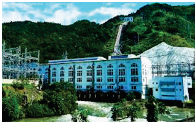
Figura 6. UHE Fontes Velha. Estrutura da casa de força (24 MW).
