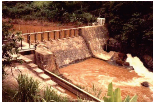
Figura 4. Usina Marmelos Zero. Detalhe do barramento vertente.
