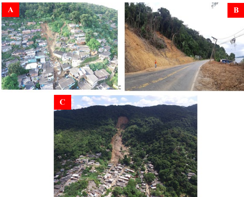
Figura 3. 3A: Escorregamento no morro da Vila Baiana. 3B: Escorregamento na Serra do Guararu com 1 óbito (Fonte: Abreu et al., 2020). 3C: Escorregamento na Barreira do João Guarda vitimando 23 pessoas.
