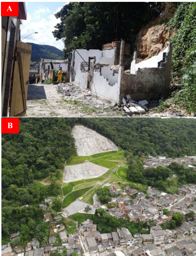
Figura 6. 6A: Demolições de moradias no Morro do Macaco Molhado. 6B: Obra de contenção no Morro do Macaco Molhado.
