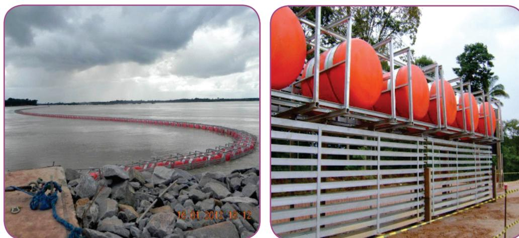
FIGURA 4 - Log boom instalado (dir.) e módulos do sistema (esq.)
