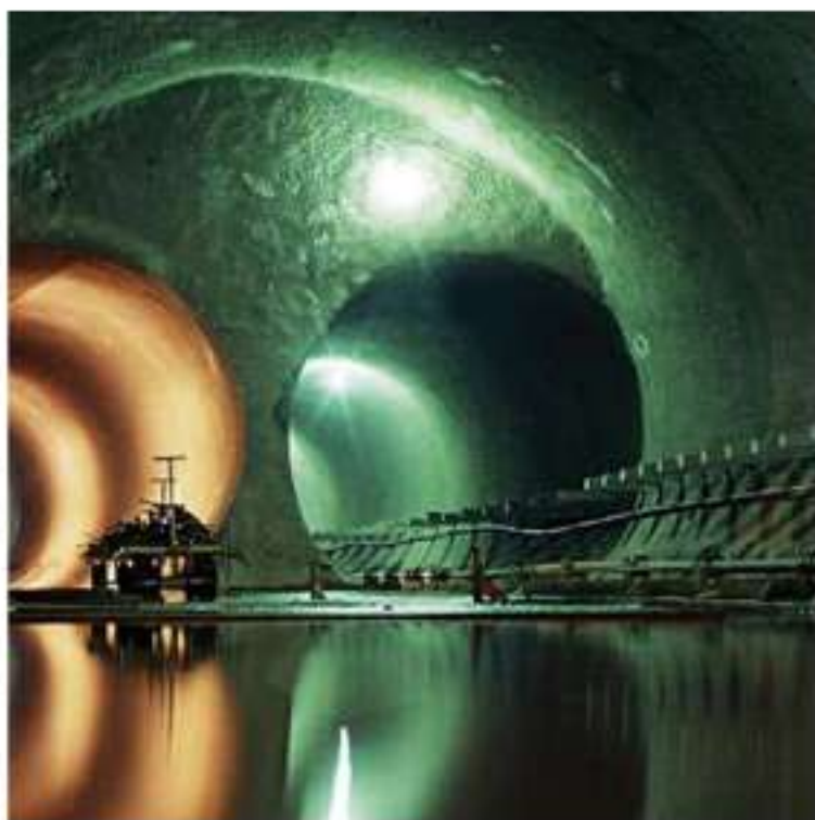
Junção de túneis do metrô de São Paulo Fonte: Túneis do Brasil
