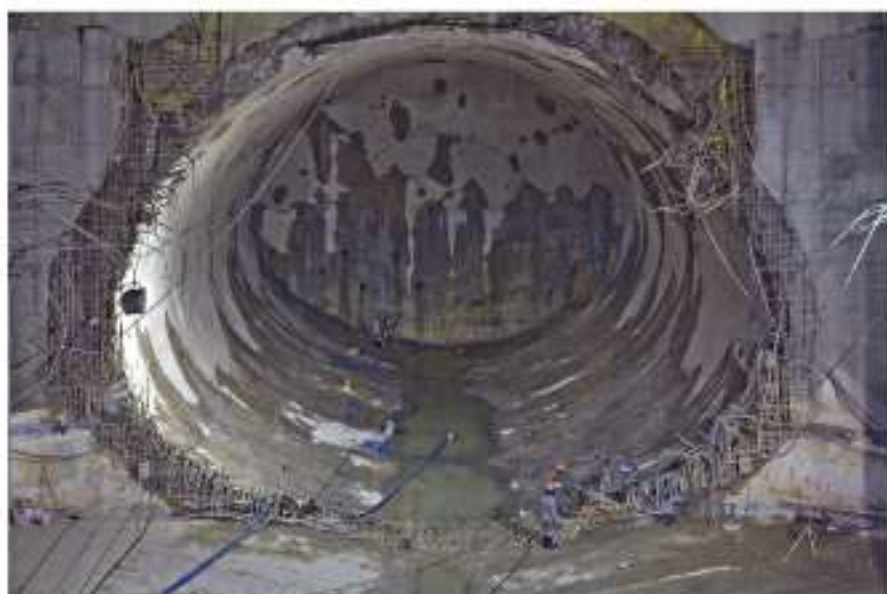
Obras do túnel Luz em andamento
