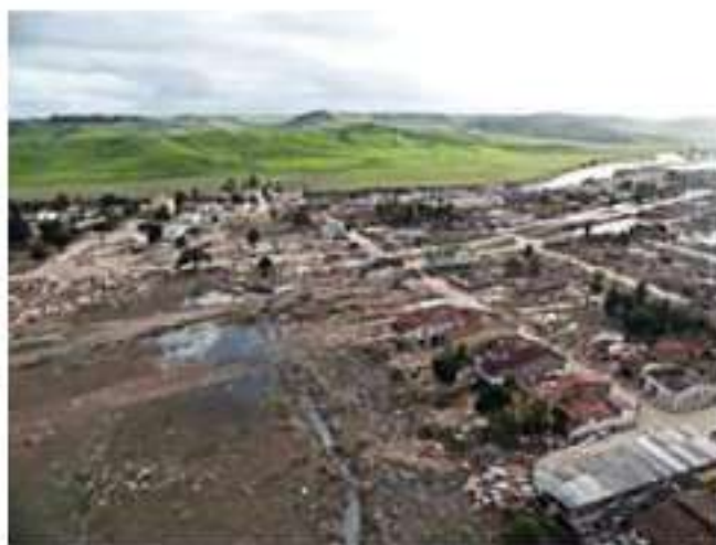
Trecho da cidade de Murici/AL, devastada pela inundação do Rio Mundaú Foto: Arquivo do IPT
