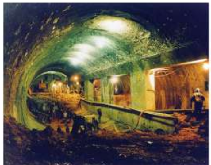
Estação Vila Madalena
