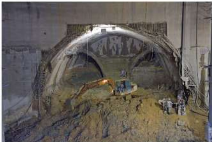
Início das obras subterrâneas da estação Luz
