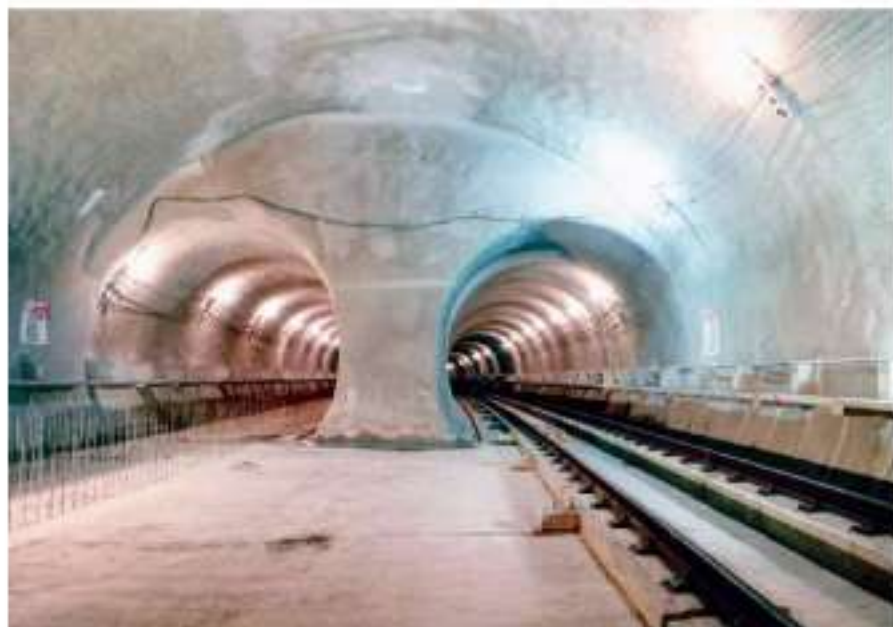
Construção do túnel Paulíctia
