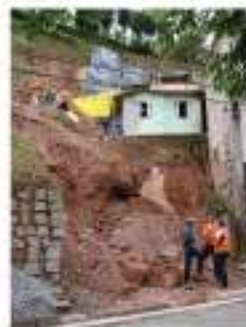
Equipes do IG/SMA e da CEDEC/SP em vistoria de área atingida por escorregamento no Jardim Zafra, Mauá em 11/01/2011. Acervo IG
