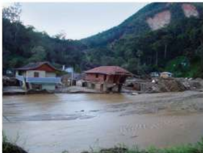
Rio Cuiabá, Petrópolis, com grande assoreamento e moradias destruídas. No trecho central da foto localizava-se uma rua com moradias dos dois lados - Arquivo IPT
