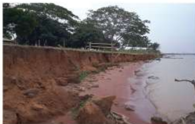
Região de Anaurilândia, MS. Exemplos do processo de abrasão gerado pelo embate de ondas e ruptura e queda de blocos dos taludes marginais. Arquivo IPT
