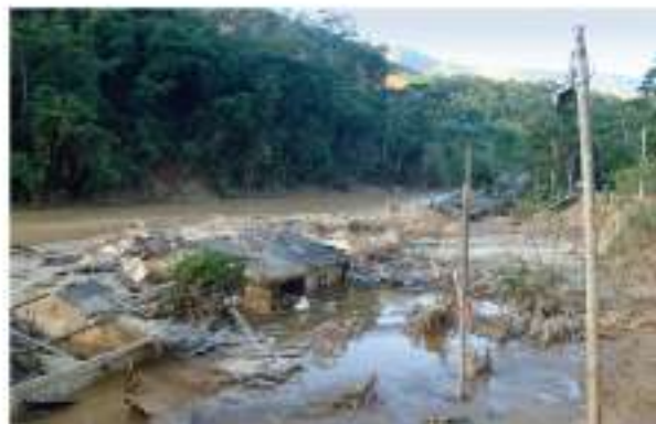
Moradias destruídas pela corrida de detritos e soterradas pelos sedimentos transportados, no vale do rio Cuiabá, em Petrópolis - Arquivo IPT
