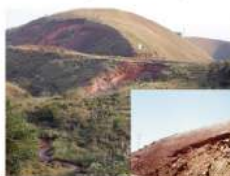
Feições de processos de escorregamento, erosão e assoreamento na rodovia Cruzeiro – Via Dutra. Foto: J. E. Zaine
