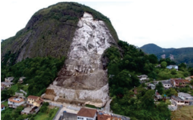
Figura 6. Dique construído com o material rochoso que deslizou da encosta. Fotos cedidas pelo DT-SDCAV.
