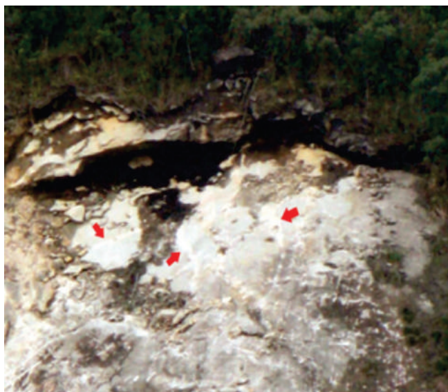
Figura 19. Veios de pegmatito disseminados pelo gnaisse na área de ruptura do movimento. Foto cedida pelo DT-SDCAV.
