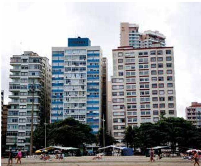
Inclinação de edifícios devido a recalques em camadas de argilas moles.
