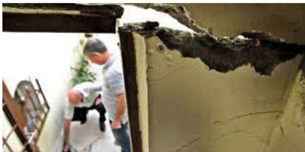
Rachaduras e danos estruturais em imóveis vizinhos a locais submetidos a rebaixamento forçado do lençol freático. Situações mais comuns em áreas baixas aluvionares com nível freático próximo à superfície
