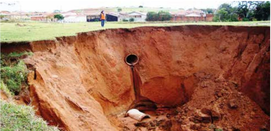
Processos erosivos remnantes decorrentes do descuido técnico na condução de águas pluviais e servidas para o exterior de zonas urbanas periféricas assentadas sobre terrenos de alta suscetibilidade à erosão. Botucatu (SP). Foto: G. Salviano
