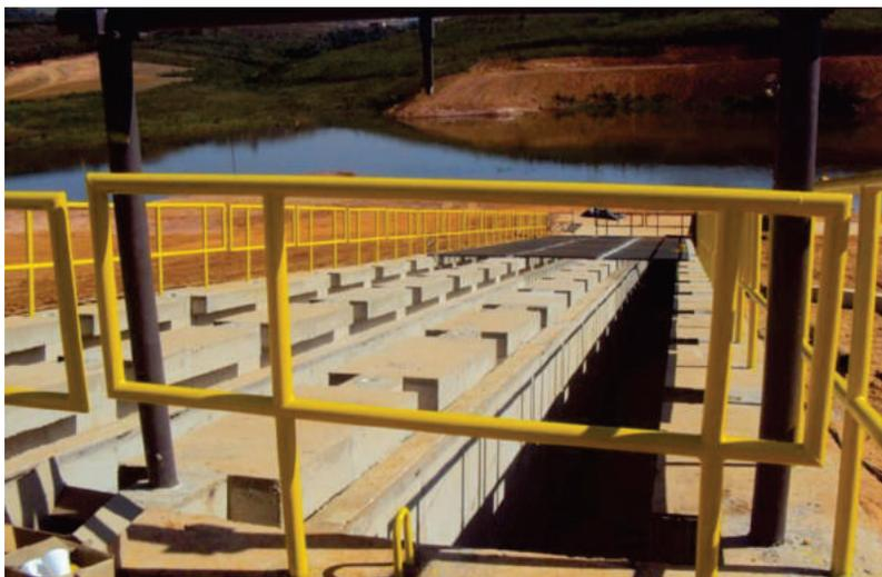
**Figura 19.** Estruturas de desvio na Barragem Forquilha V em Ouro Preto e Congonhas (MG). Fonte: Site da Internet.
