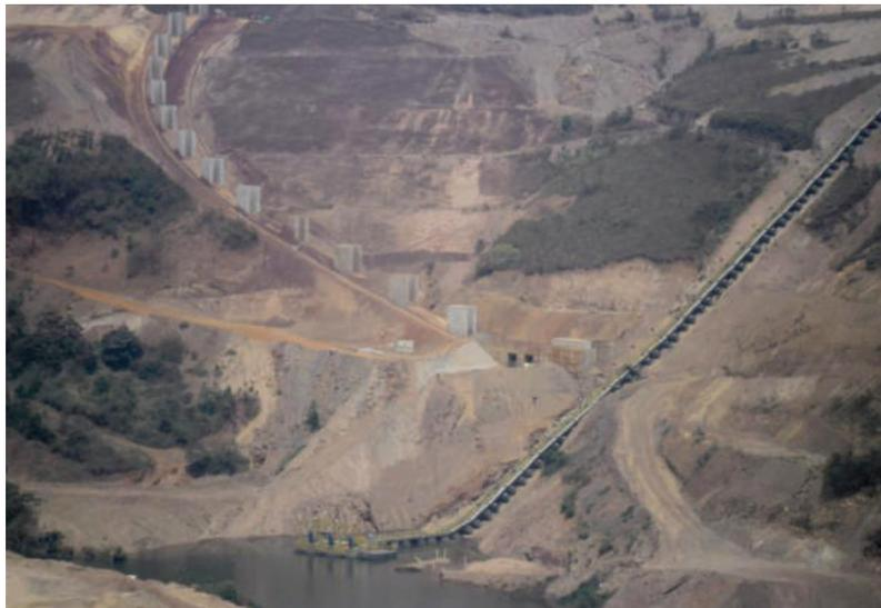
**Figura 17.** Estruturas para desvio na Barragem Forquilha IV em Ouro Preto e Congonhas (MG). Fonte: Site da Internet.
