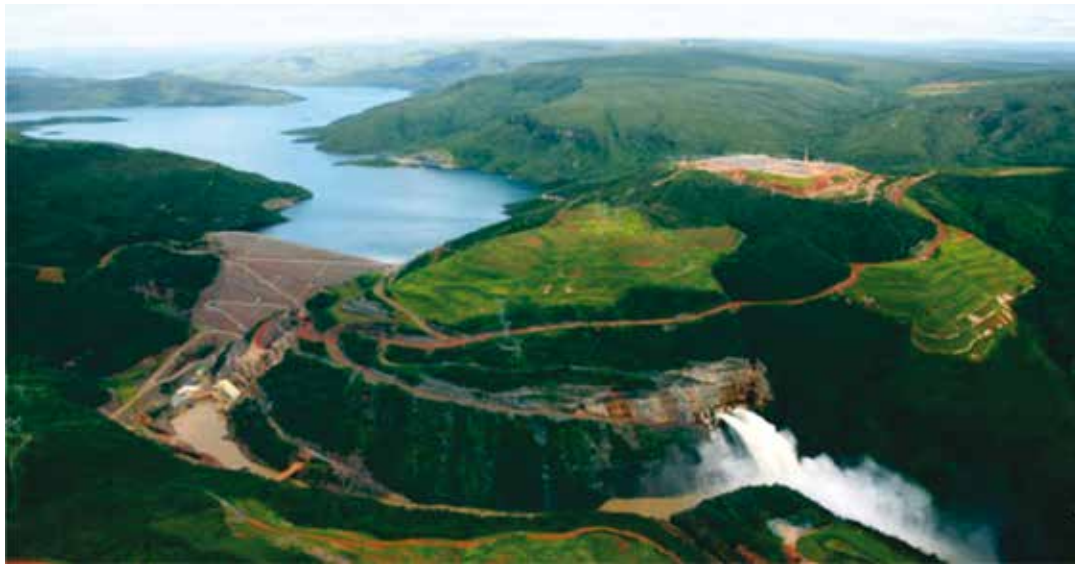
Figura 8. UHE Irapé – Arranjo com Circuito Adutor. Situada no rio Jequitinhonha, Minas Gerais, possui a maior barragem do Brasil e a segunda maior da América Latina, com 205 m de altura. Possui 360 MW de potência instalada. O arranjo compreende uma barragem de enrocamento com núcleo de argila fechando o vale, túneis de desvio na margem direita, tomada de água, vertedouro e extravasor na margem esquerda e casa de força a jusante da barragem.
