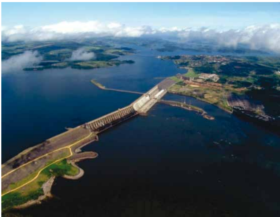
Figura 5. UHE Tucuruí – Arranjo Compacto. Situa-se no trecho baixo do rio Tocantins, no Estado do Pará, com potência de 8.125 MW. A barragem tem 95 m de altura e comprimento de 7 km. O vertedouro da usina, um dos maiores do mundo, tem 23 vãos de 20 m largura e 21 m altura e capacidade de vertimento (Q) de 110.000 m 3 /s.
