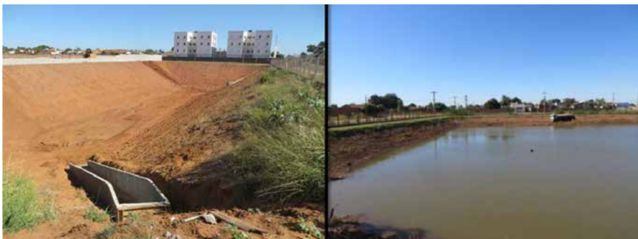
Figura 28. Bacia de contenção de águas pluviais e em operação, Três Lagoas, 2019 (Antoneli et al. 2019).
