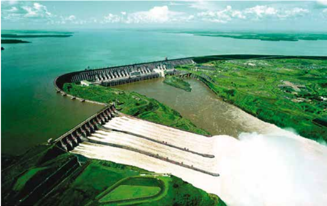
Figura 6. UHE Itaipu - Arranjo Compacto. Situa-se no rio Paraná e tem potência de 14.180 MW. A barragem tem 196 m de altura e 7,8 km comprimento. O vertedouro tem 14 vãos de 20 m largura e 21,34 m altura e capacidade de vazão de 62.000 m 3 /s.
