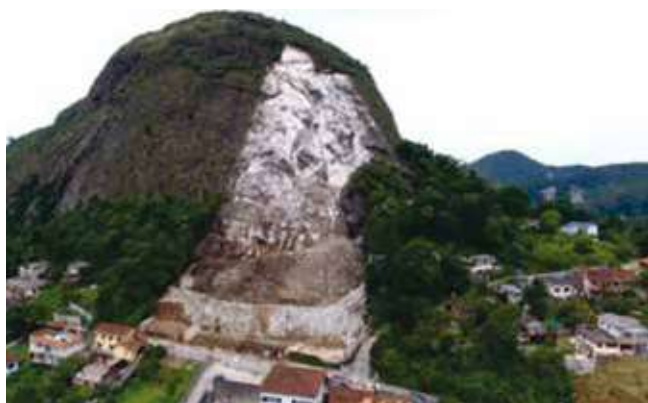
Figura 6. Dique construído com o material rochoso que deslizou da encosta. Fotos cedidas pelo DT-SDCAV.
