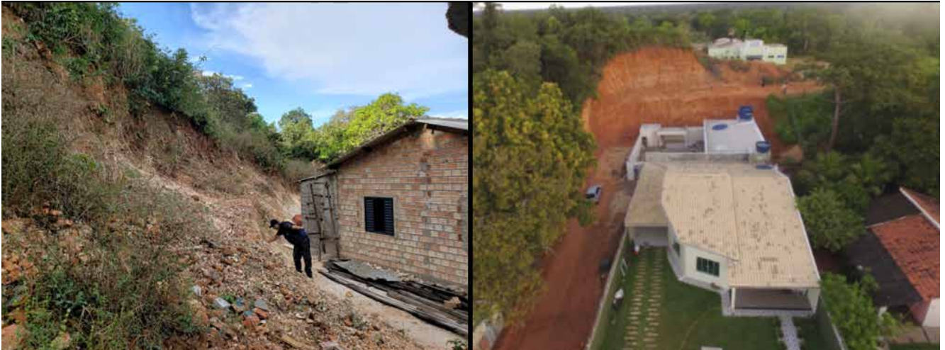
Figura 17. Locais atingidos por deslizamento, Santa Terezinha, 2019 (Silva et al, 2019).
