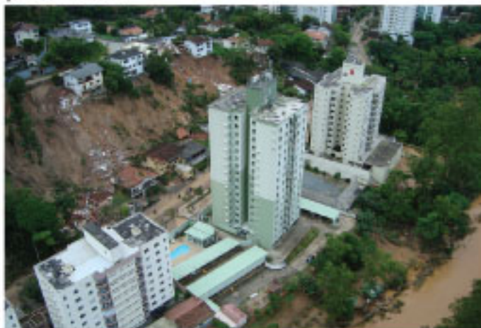
Escorregamento em área urbana, na cidade de Blumenau, SC
