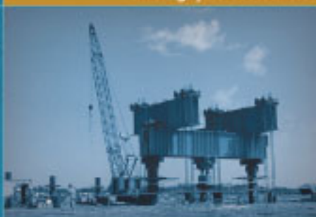
Controle de Qualidade em Fundações
