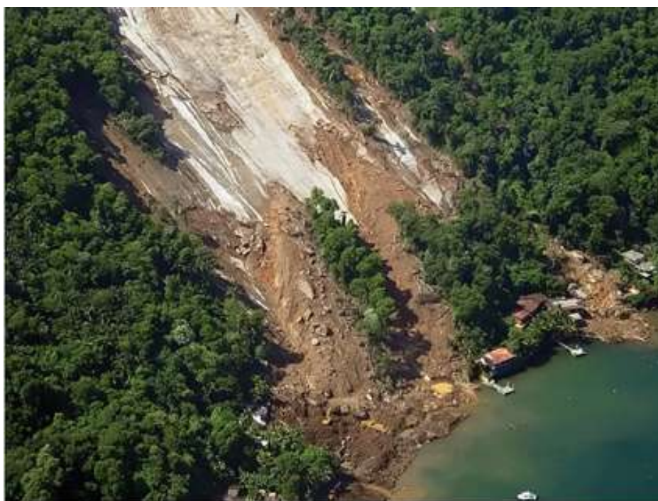
Detalhe do escorregamento da Enseada do Bananal, vendo-se o que restou da pousada, ao pé da massa que escorregou.
