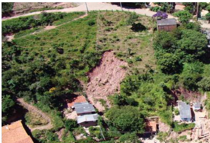
Escorregamento planar raso ocorrido em cabeceira de drenagem na área urbana do município de Cunha. Notar dimensões dos taludes e vulnerabilidade das moradias.
