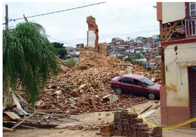
Igreja Matriz de São Luiz do Paraitinga em escombros, após a inundação.
