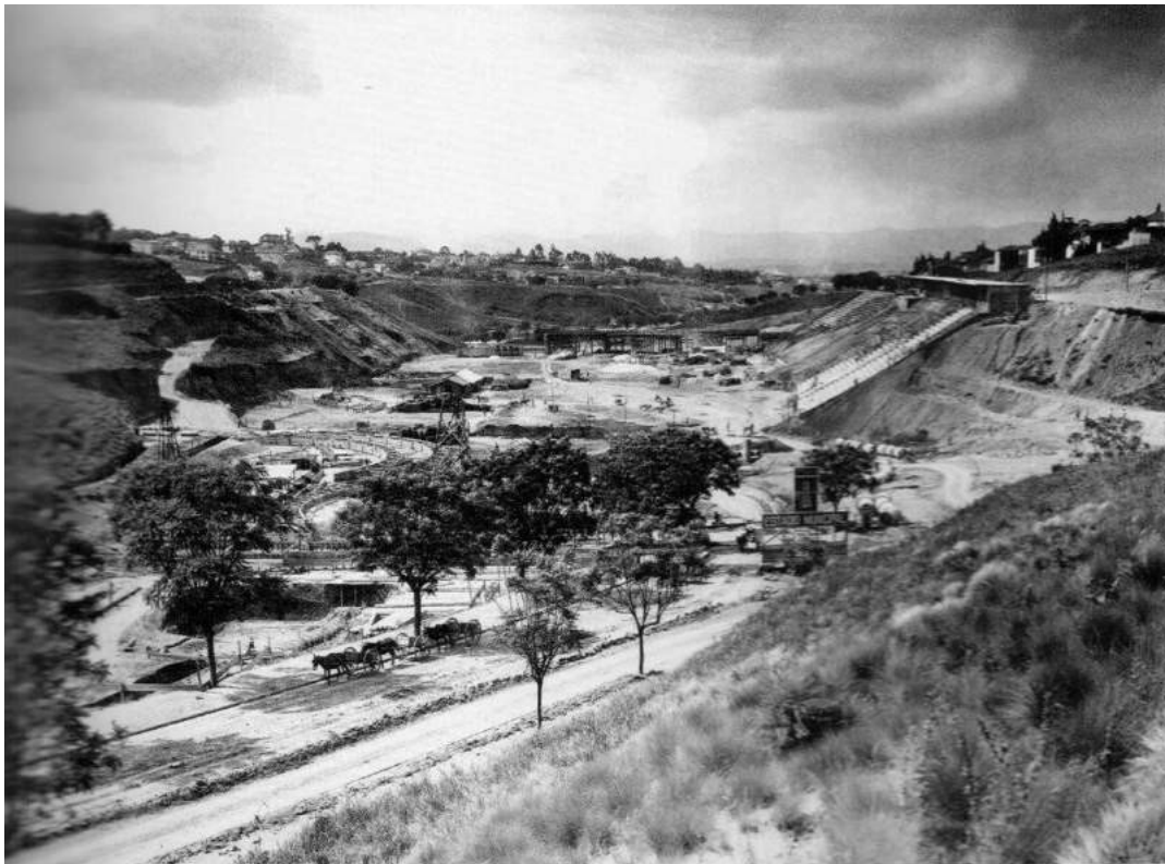
Figura 7. As obras em andamento, com as arquibancadas sendo “acomodadas” nos flancos do vale.
