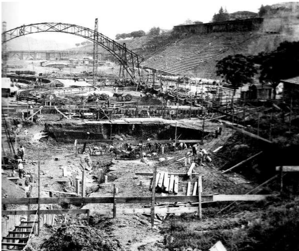
Figura 8. Detalhe do canteiro de obras.
