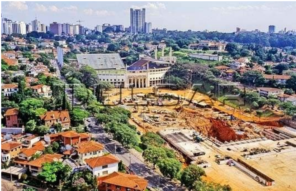
Figura 13. Obras do piscinão na Praça Charles Miller.
