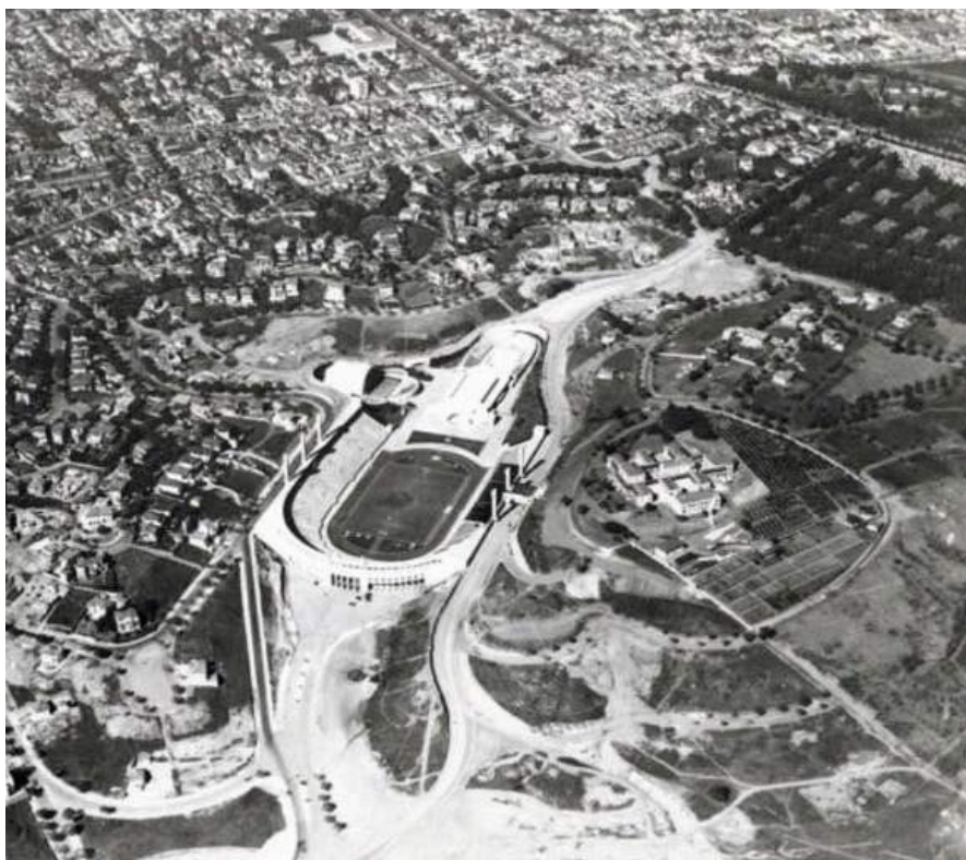
Figura 10. As obras de construção do Estádio do Pacaembu já praticamente concluídas. Notar que as conformações geomorfológicas do terreno natural original foram essencialmente respeitadas e mantidas.
