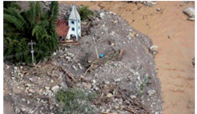
Figura 1. Igreja em Teresópolis afetada por movimento de massa em janeiro de 2011. Fonte: site de Internet.
