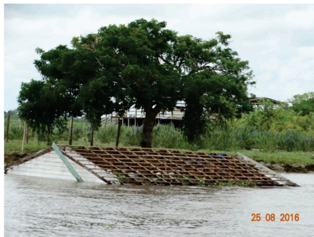
Figura 4. Casa de madeira levada por processo de solapamento de margem na comunidade São Braz, município de Porto de Moz. Fonte: Pará (2016).
