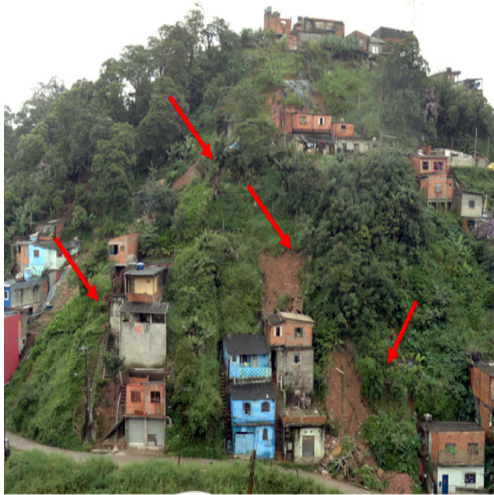
Figura 2. Ocupação de população de baixa renda, em situações de risco, com desmatamento e cortes em taludes com declividade acentuada e concentração da drenagem superficial, no município de Rio Grande da Serra, SP. Fonte: Arquivo IPT.
