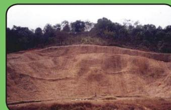
**Foto 2** - Controle da erosão com técnicas de bioengenharia, com biomantas antierosivas, bermas artificiais com bermalonga® e vetiver.
