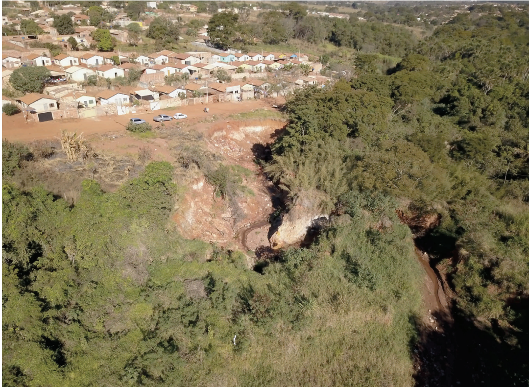
Figura 1. Erosão típica próxima a residências. Aparecida de Goiânia, 2017 (Autor: Fernandes, Rodrigo Luiz Gallo)
