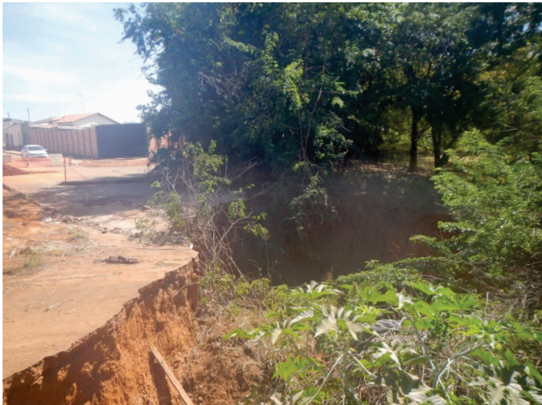
Figura 2. Erosão formada pela má gestão das drenagens pluviais, avançando a residências. Aparecida de Goiânia, 2017 (Autor: Fernandes, Rodrigo Luiz Gallo)
