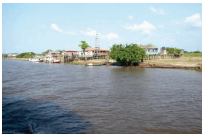
Figura 6. Moradias de madeira instaladas num terreno muito susceptível a erosão fluvial, comunidade São Braz. Município de Porto de Moz – PA.
