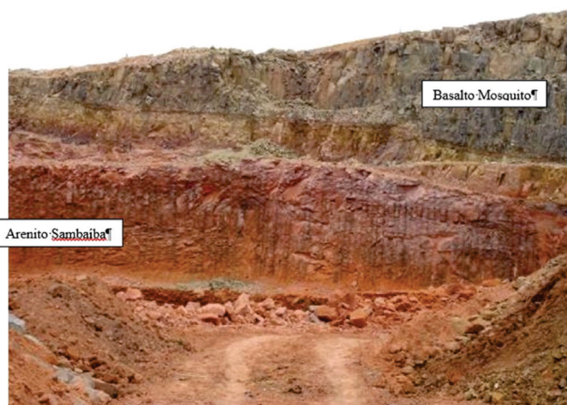
Figura 2. Talude de escavação para a implantação do circuito de adução e geração da usina mostrando o contato entre o Arenito Sambaíba (base) e o Basalto Mosquito (topo)
