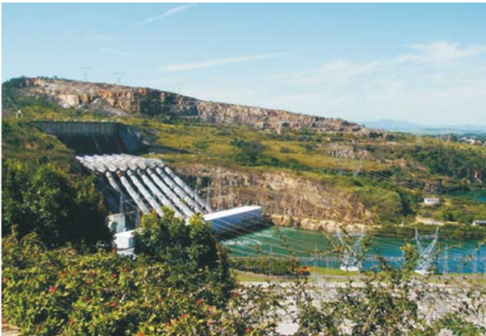
Figura 5 – Usina Hidrelétrica de Furnas com rocha aflorante, localizada no rio Grande, Minas Gerais.
