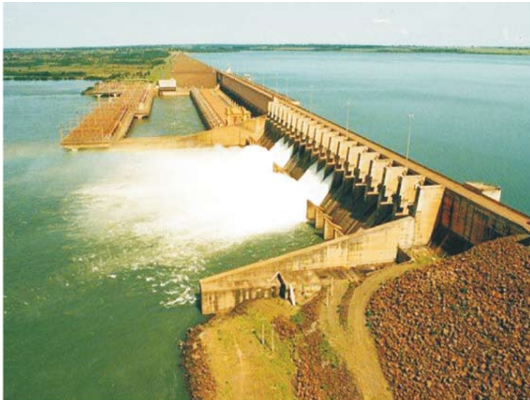
Figura 1 – Barragem de Ilha Solteira, concluída pela CESP em 1978. Fonte: Exame.com (2011).
