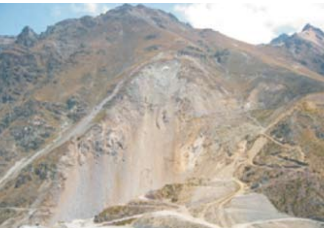
Figura 13 – Vista frontal do talude da cava.
