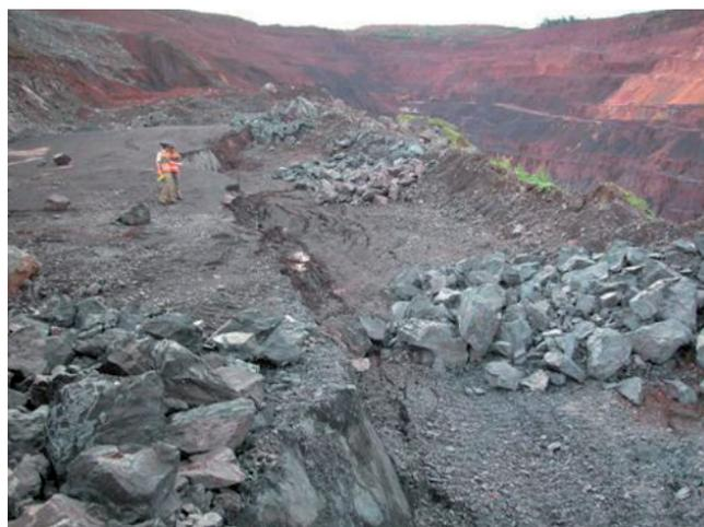
Figura 8 - Vista da crista com surgimento de trincas e recalques.
