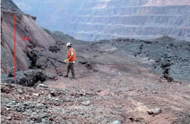
**Figura 11** – Ruptura através do plano de contato de lapa (máfica decomposta x hematita) mostrando recalque de 3 m na crista da ruptura.
