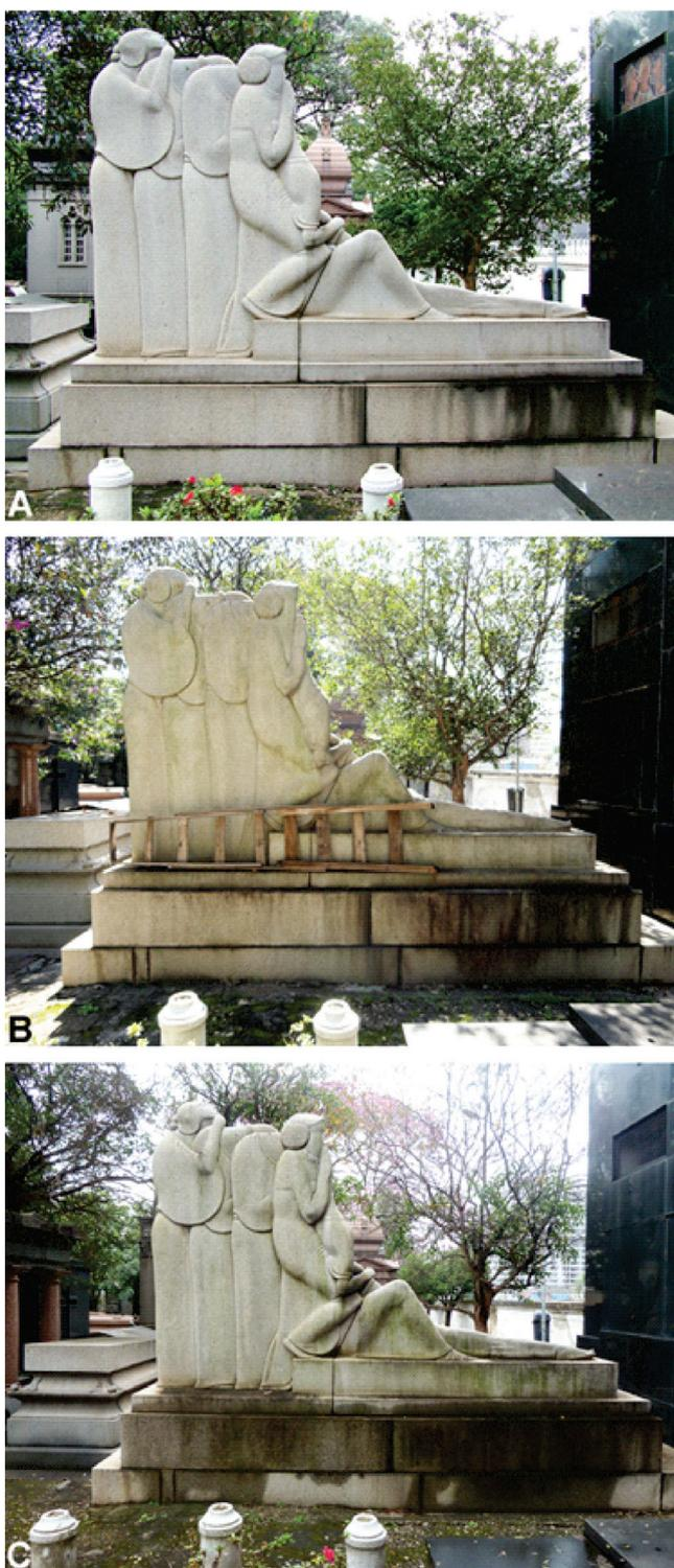
**Figura 4** - Aumento nas proporções da área de abrangência da alteração cromática e da colonização biológica. A. 2008. B. 2013. C. 2015.
