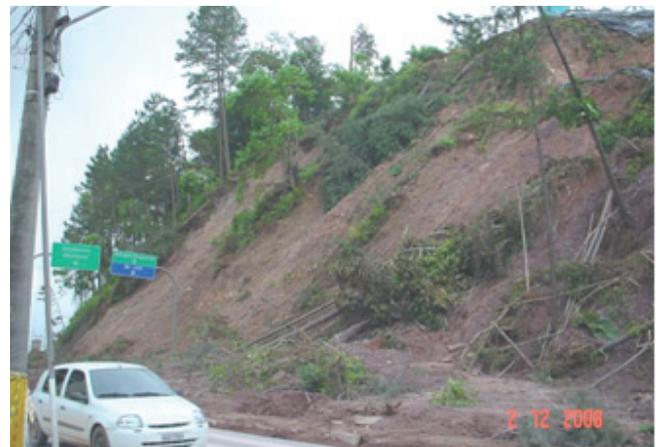
**Figura 2** – Deslizamentos rasos em encosta vegetada devido à chuva intensa (Gaspar, SC, 2008) – movimento rápido, interrupção da via, pequena frequência (foto de L.A. Bressani).
