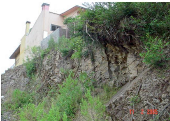
**Figura 3** – Deslizamento potencial de blocos de rocha ao longo de descontinuidades (Caxias do Sul, 2005) – estável até o momento (2016), frequência (??) – (foto de L.A. Bressani).
