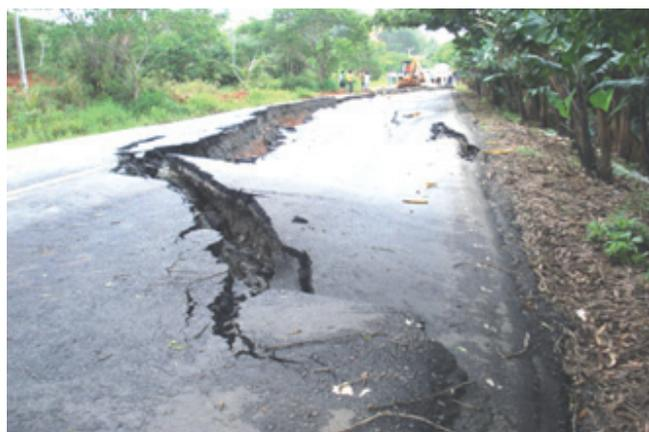
**Figura 4** – Escorregamento semi-rotacional, grande área, pequeno aterro sobre depósito de solo (aluviões), movimento de baixa velocidade após longo período de chuvas (Luis Alves, SC) – (foto de L.A. Bressani).
