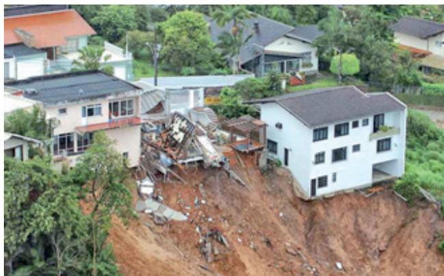
**Figura 5** – Escorregamento semi-rotacional em ambiente construído. Movimento rápido durante chuvas intensas (Blumenau, SC, 2008). Suscetibilidade induzida (foto de autor desconhecido, disponível na web).
