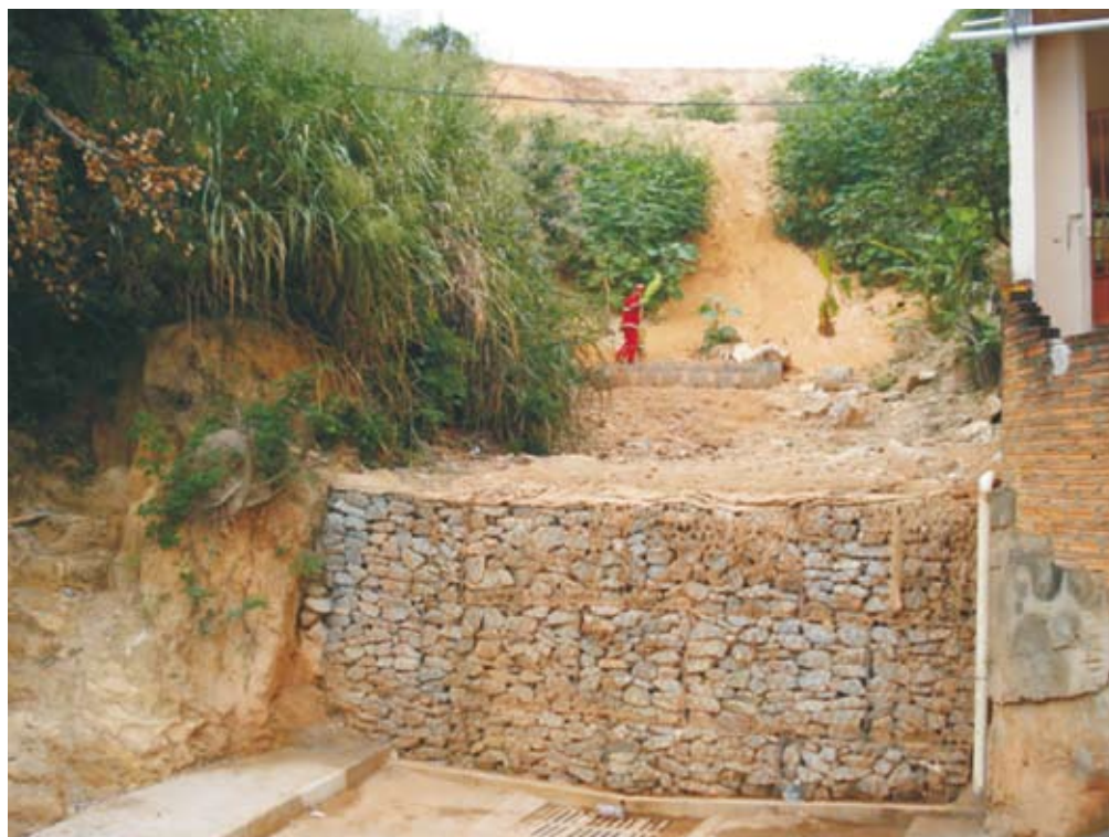
Figura 10. Foto do aterro de resíduos em execução em 2009, na rua Flor do Campo, em Belo Horizonte.
