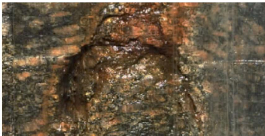
**Figura 19** – Oxidação evidente e surgência de água no interior do furo.
