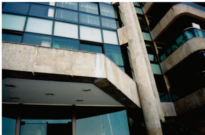
**Figura 1** - Aspecto de revestimento em rocha, exposto a nevoa salina na orla de Recife, exibindo eflorescências e manchamentos esbranquiçados, decorrentes da cristalização de sais.
