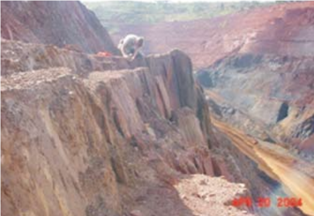
Figura 12 – Cisalhamento reverso na zona inferior do talude com foliação com alto ângulo devido a mecanismo de cisalhamento superior e deformação horizontal na base.
