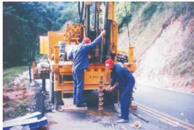
Figura 7 - Equipamento de trado oco com martelo automático para ensaio SPT.
