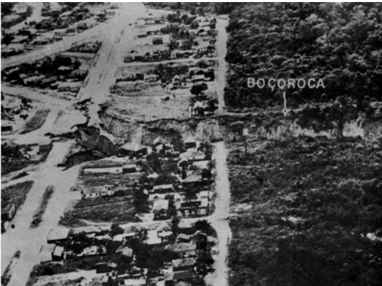
Figura 5 - Vista aérea parcial de uma das boçorocas que afetaram a cidade de Cianorte, PR, Sobre solos que capeiam o arenito Caiuá.
