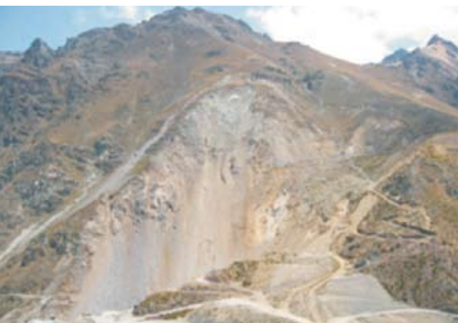
Figura 13 – Vista frontal do talude da cava.
