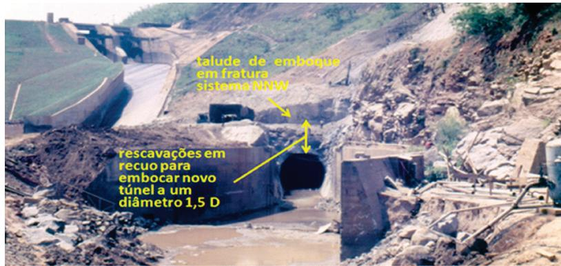
**Figura 5** - Vista de jusante - escavações em canal, para embocar a reescavação. Observa-se a superfície do talude frontal, onde foi implantado o emboque no plano de uma fratura do sistema NNW, oblíquo ao eixo do túnel (arquivo pessoal).
