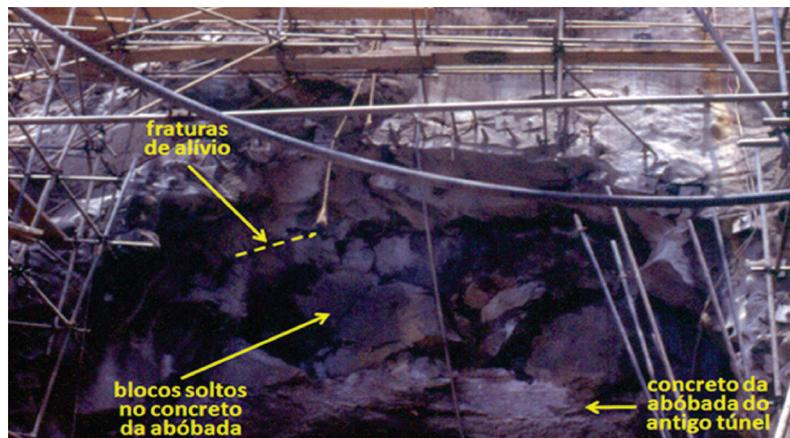
**Figura 7** - Observa-se que a instabilidade do maciço classe II no contorno do 1º passo de avanço do emboque, antes (figuras 6a e 6b) e pós desmorte (esta foto), foi influenciada pela interseção dos sistemas de fraturamentos: (1) NNW; (2) bandamento oxidado do granito gnaissé; e (3) de alívio de tensão induzido pelas escavações do antigo túnel, que condicionaram desarticulação dos blocos sobre o concreto de abóbada (arquivo pessoal).
