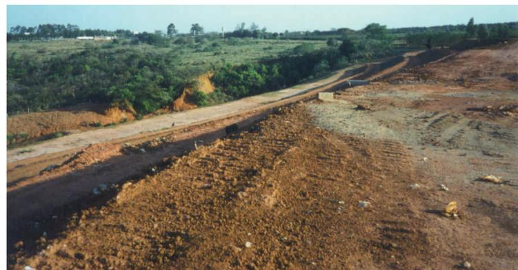
**Foto 8** - Boçoroca de cabeceira de drenagem, aterrada com lixo doméstico. Há alguns anos foi transformada no Aterro Sanitário e atualmente está com sua capacidade quase esgotada.
