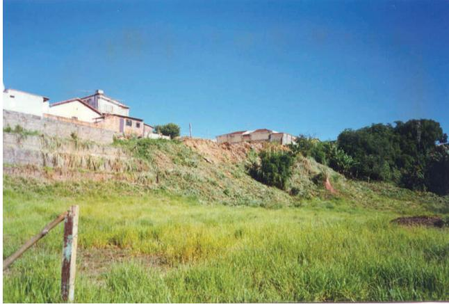
**Foto 1** – Boçoroca recuperada, por meio de obras de drenagem e contenção dos taludes. Apesar das obras, ainda há algumas moradias em situação de risco.
