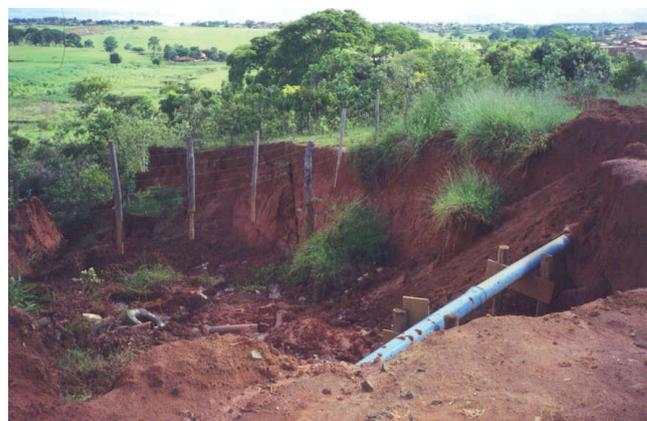
**Foto 10** – Boçoroca desenvolvida pela concentração da água superficial. Observa-se o rompimento da adutora de água do loteamento em consolidação. Este loteamento apresenta infraestrutura deficiente (ruas sem pavimentação, sistema de drenagem precário, etc.).
