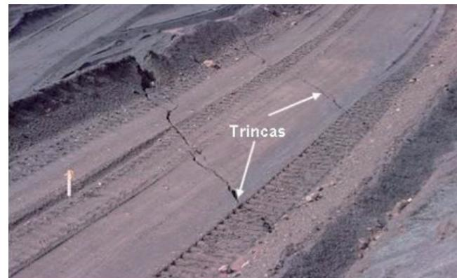
**Figura 5** – Surgimento de trincas no Talude Sudeste de N4E, banco 615 m.
