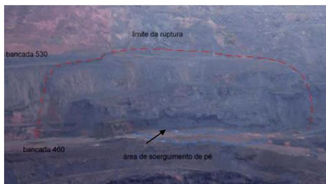
Figura 9 - Vista frontal da área de instabilidade de outubro de 2007, talude sul/sudeste da mina N4E.
