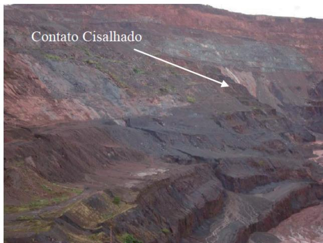
Figura 10 - Vista do flanco sul/sudeste de N4E. Contato cisalhado de lapa entre a formação ferrífera e a rocha metabásica.
