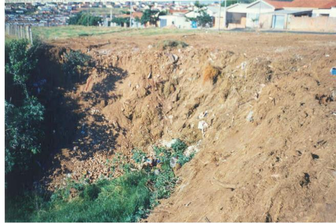
**Foto 2** – Cabeceira da erosão parcialmente aterrada com lixo; inclui também resíduos da indústria de couro.
