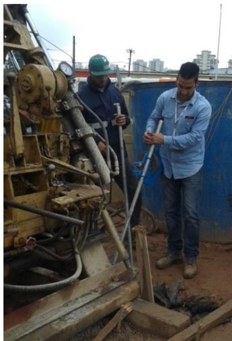
Foto 3 - Equipamento sendo montado em furo inclinado, obra do Metrô de São Paulo, Largo do Taboão da Serra, SP (arquivo pessoal).
