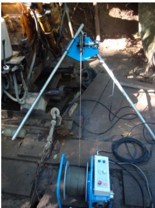
Foto 2- Equipamento montado para iniciar filmagem, obra do Metrô do Rio de Janeiro, região da Gávea, RJ (arquivo pessoal).
