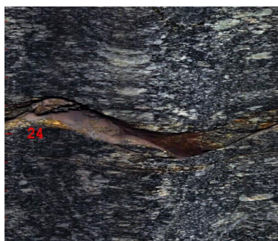
Foto 25 – Fratura aberta, com preenchimento de fragmentos de rocha (D5). Provavelmente restante do preenchimento arenoso foi lavado (D5/D6). Fonte: Metrô-SP.
