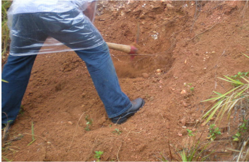
Figura 6.2 – Coleta da amostra deformada.
