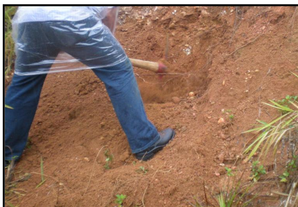
FIGURA 11: Coleta de solo deformado, ponto de amostragem SA. Sígolo, J. B.; Rodrigues, V. G. S.
