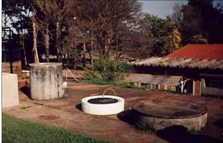
Figura 2.2- Biodigestor de modelo chinês (MARTELLI, 2011)
