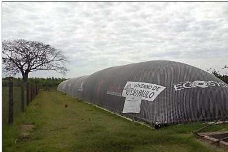
Figura 2.4- Biodigestor de modelo canadense (MARTELLI, 2011)
