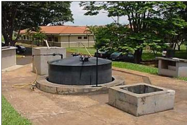
Figura 2.3- Biodigestor de modelo indiano (MARTELLI, 2011)
