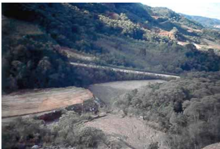
Foto 04 - Depósito de rejeitos de uma pedreira situada no município de Campo Largo.
