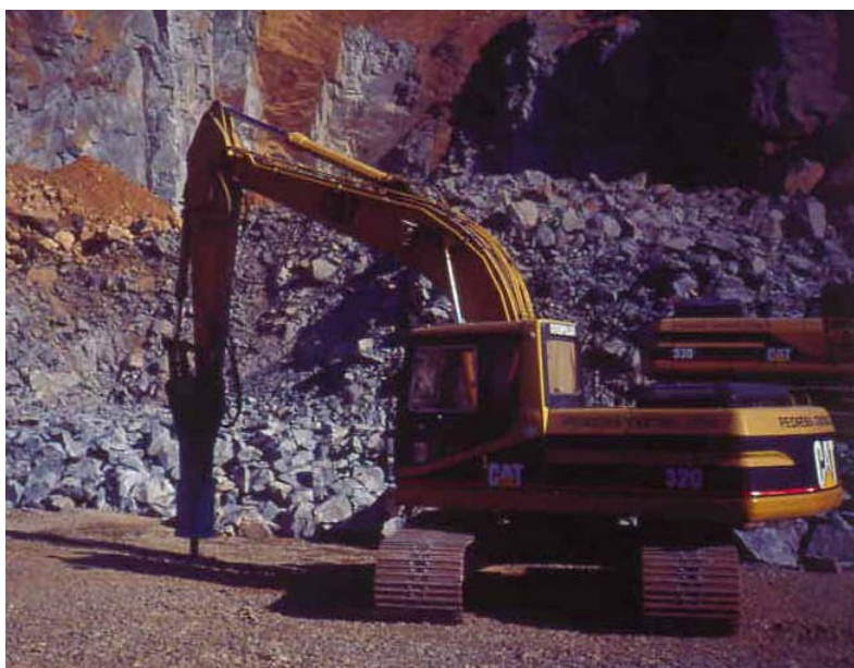
Foto 08 - Rompedor utilizado para redução do tamanho de blocos detonados.
