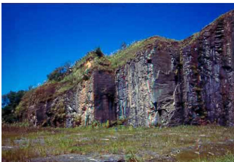
Foto 01 - Pedreira em bancada única com altura acima do ideal recomendado.
