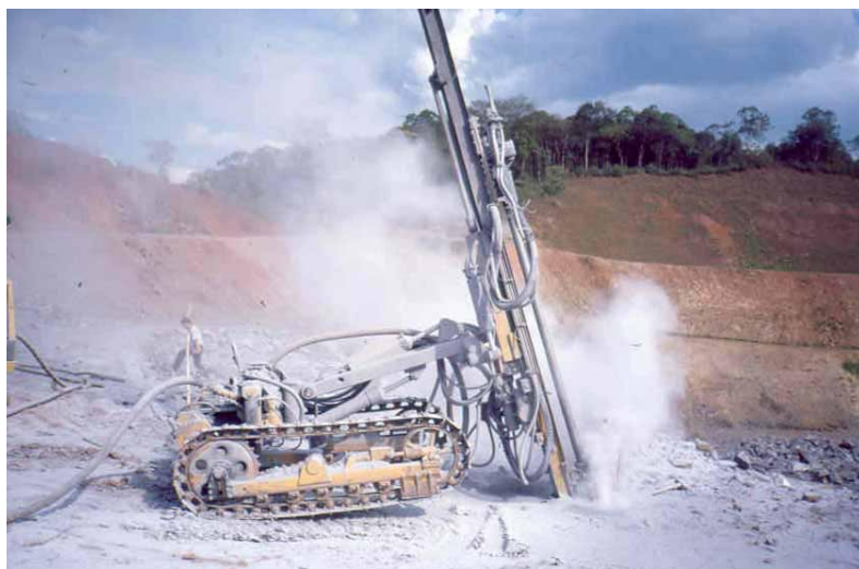
Foto 06 - Perfuratriz de carreta na operação de abertura de furo inclinado.
