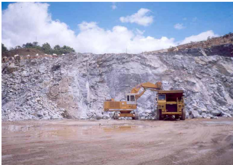
Foto 09 - Carregamento de rocha detonada à ser transportada à usina de britagem.
