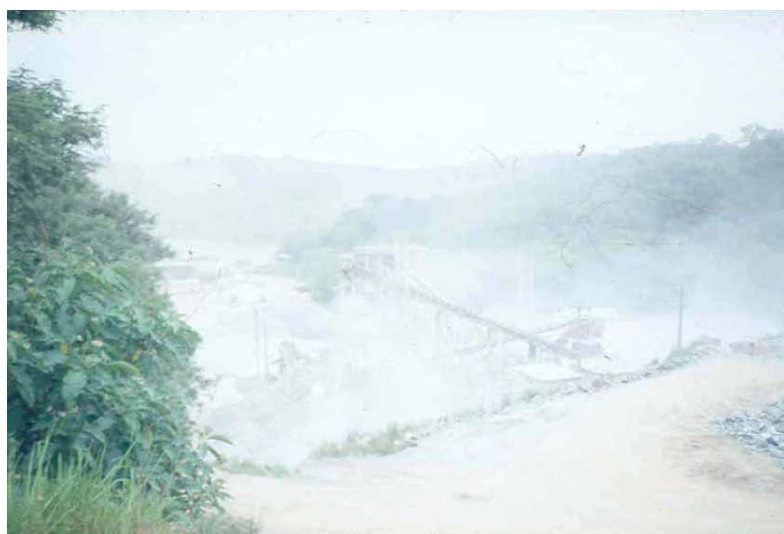
Foto 13 - Usina de britagem com os equipamentos de controle de poeira desativados.
