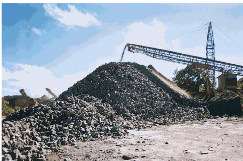
Foto 12 - Esteira transportadora e estoque intermediário de rocha britada.
