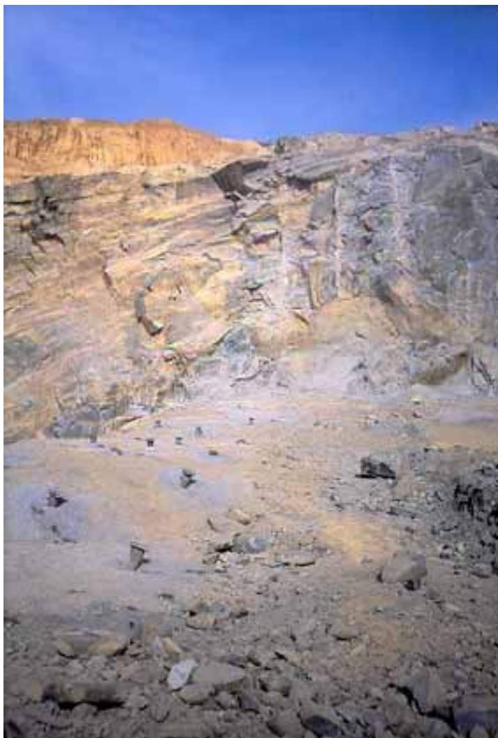
Foto 07 - Malha de furos abertos, aguardando serem carregados com explosivo
