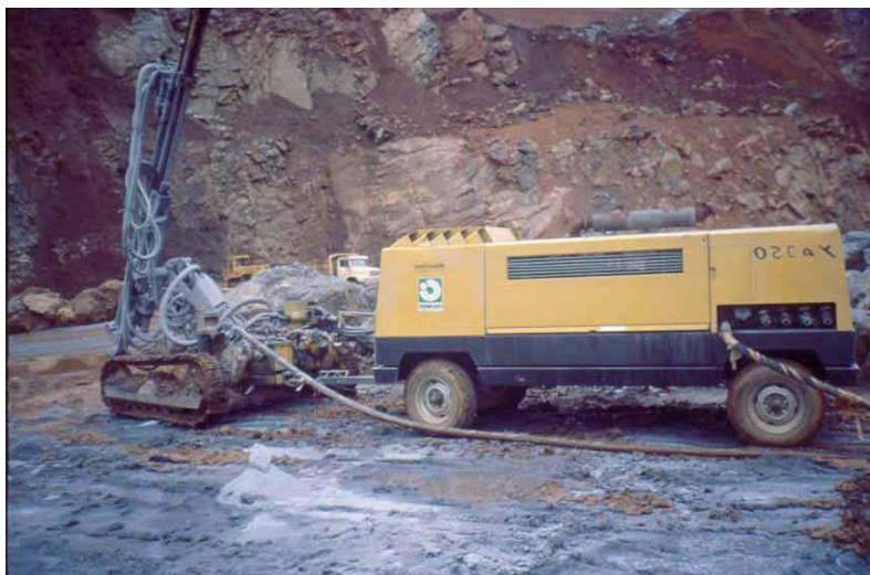
Foto 05 - Compressor de ar movido por motor à diesel e atrelado a uma perfuratriz
