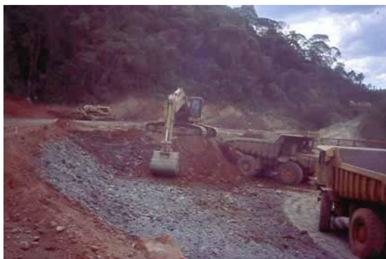
Foto 03 - Retroescavadeira removendo o material estéril de cobertura.
