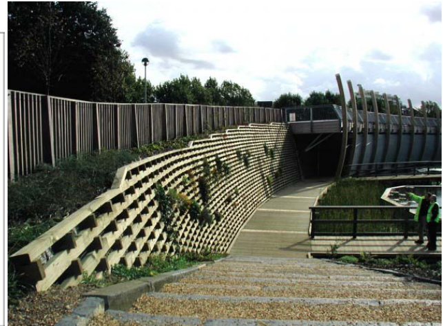
Figura 18: Aplicação do muro em fogueira ( crib wall ) no Mile End Park, Londres, com a aplicação de estacas de madeira e altura de 7,8 metros ( http://www.phigroup.co.uk/tags/retaining-walls/mile-end-park-stepney-london )
