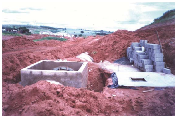
Figura 31: Exemplo de galeria em construção em São Pedro – SP (FERREIRA, 2004).
