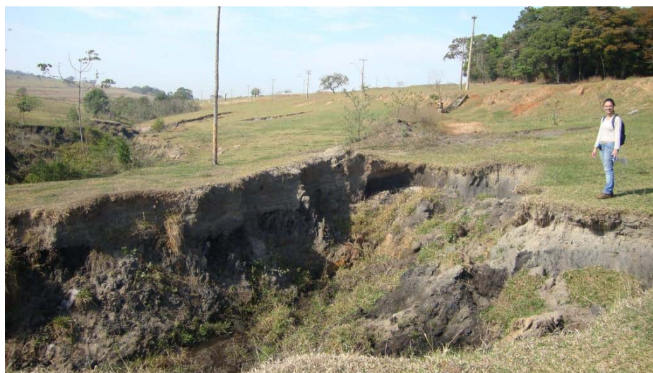
Figura 44: Voçoroca F3, bastante ativa, localizada na margem direita do córrego.
