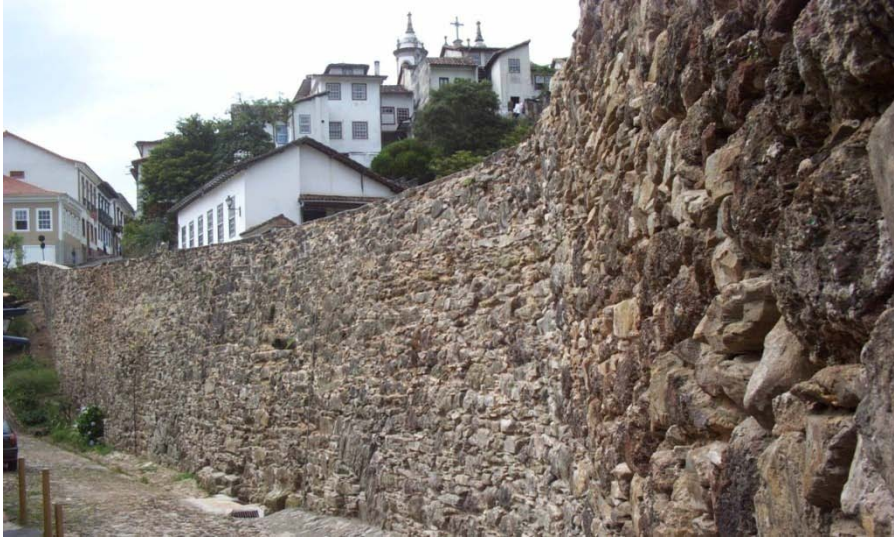
Figura 23: Muro de blocos de rocha em Ouro Pedro- MG.
