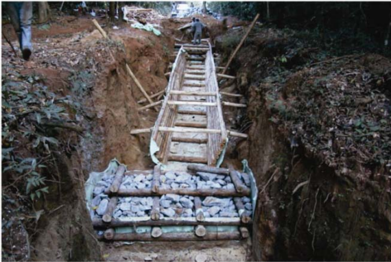
Figura 28: Construção do canal principal e da canaleta, integrantes do sistema de drenagem da recuperação da voçoroca do Jardim Botânico de Goiânia – GO (SPONGA e COELHO, 2001).
