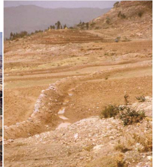
Figura 26: Cordão de pedras preenchido com solo rico em fragmentos de rocha (NYSSSEN et al , 2007).
