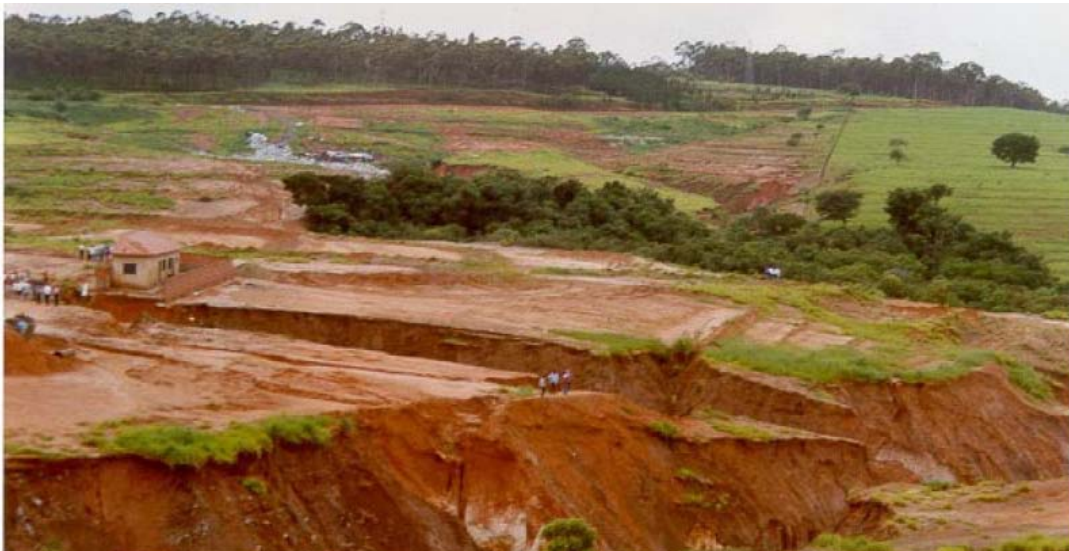
Figura 14: Feição erosiva que havia sido aterrada e foi reativada no município de São Pedro – SP (FERREIRA, 2004).
