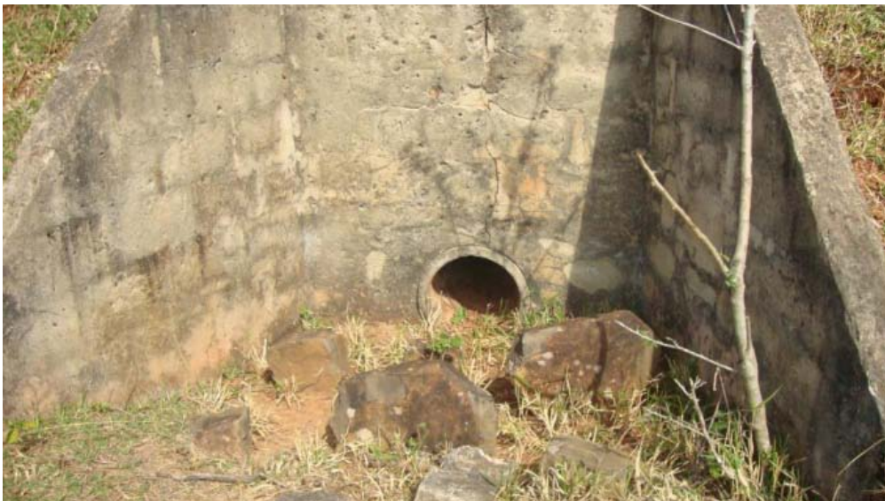
Figura 54: Blocos de rocha dispostos na frente de uma saída de tubulação para contenção da velocidade do escoamento.
