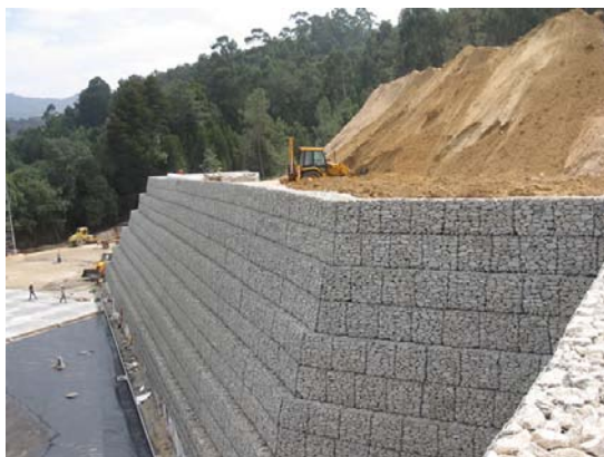
Figura 19: Exemplo de aplicação de um muro de gabião ( http://www.projectista.pt/produto/muros-de-gabioes-santos-mouta-2/ )
