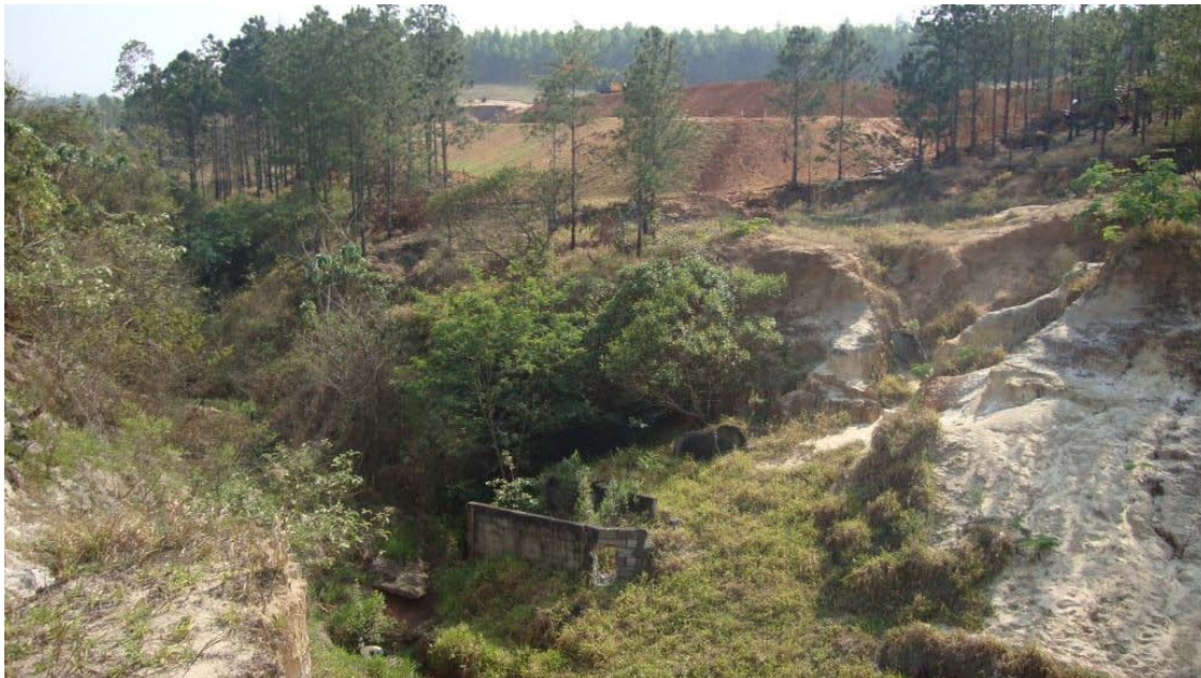
Figura 61: Feição F2, com destaque para a presença de água no interior.
